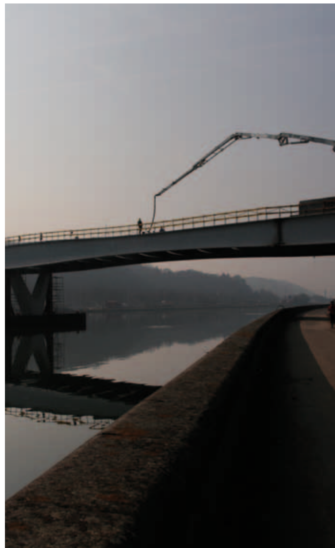
Nouveau pont d'accès au terminal Liège Trilogiport. ©SPW-DPVNI
