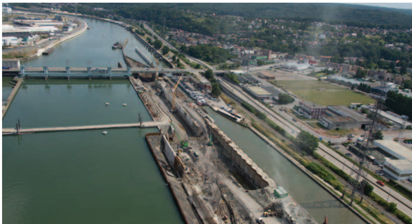
Le site d'Ivoz-Ramet en cours de chantier en 2013 ©SPW-Direction de l'Édition
