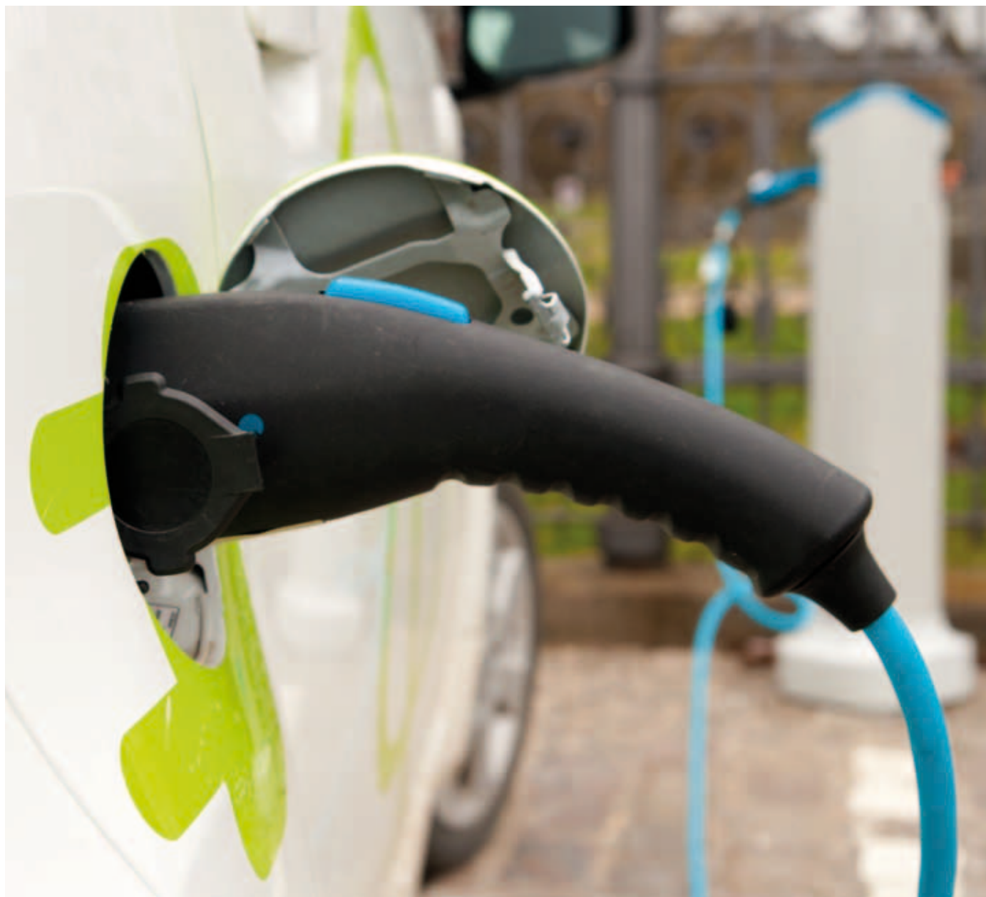
Bornes de recharge pour voitures électriques.
