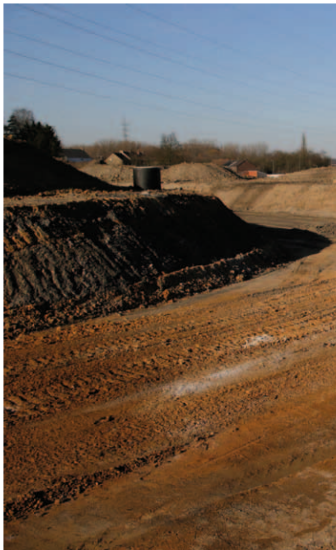
Zone du Grand Ban : construction des voiries. ©SPW-DPVNI
