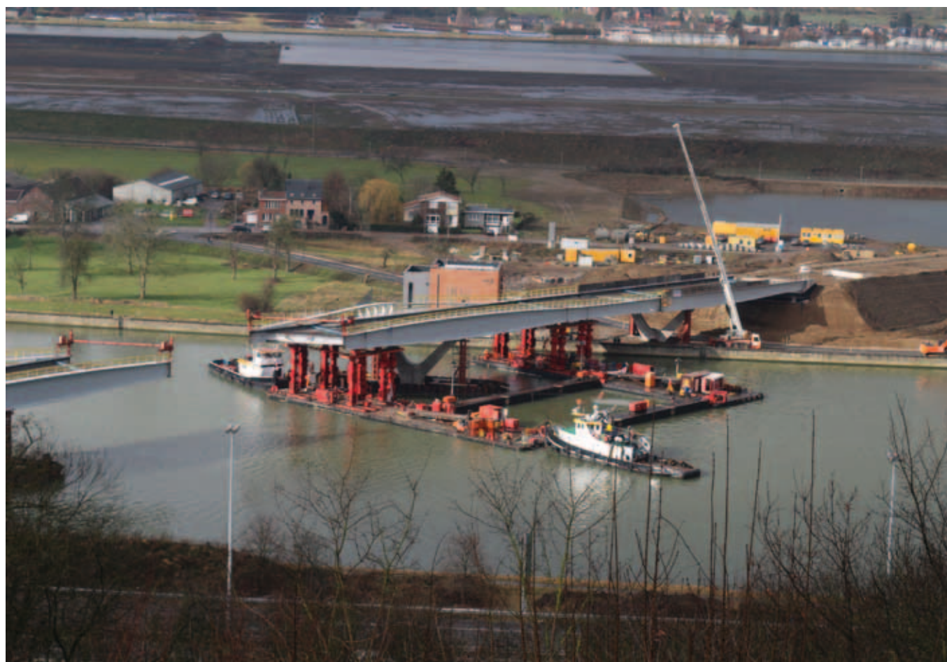
Liège Trilogiport : pont d'accès et dalle du terminal à conteneurs (à l'arrière plan). ©SPW-Voies hydrauliques de Liège
