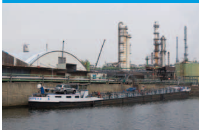
Installations de transbordement de produits liquides. ©SPW-DPVNI
