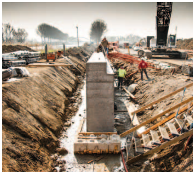
Construction d'un mur de quai à Pecq. ©Voies hydrauliques de Tournai
