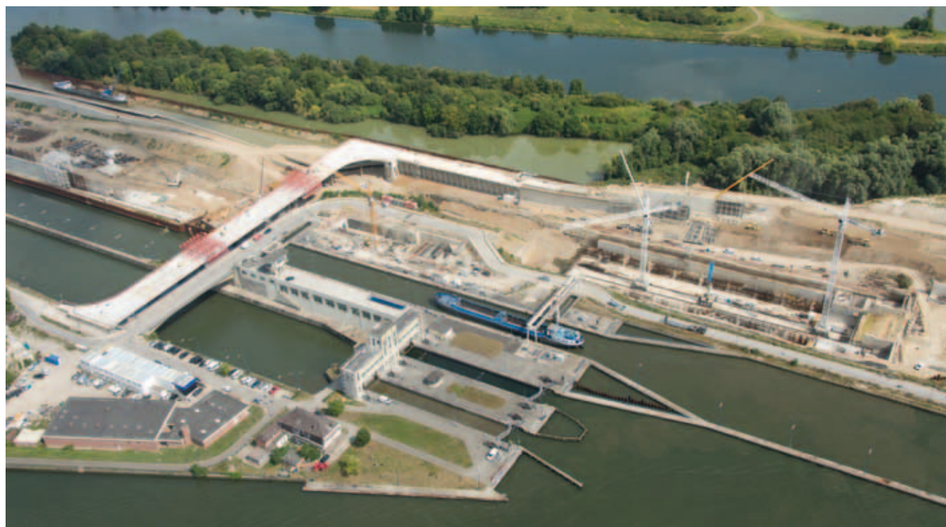
Le site de Lanaye en cours de chantier en 2013. ©SPW-Direction de l'Édition
