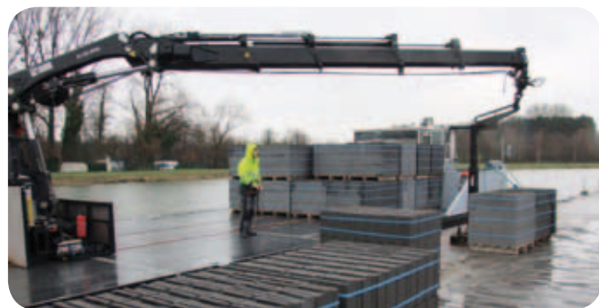
Chargement de palettes de blocs de béton au quai de Manage. ©Mathilde Avaert-Roosens Béton
