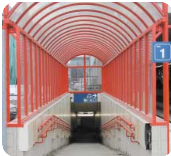
Rampe d'accès aux quais "adaptée" aux personnes à mobilité réduite et aux vélos.
