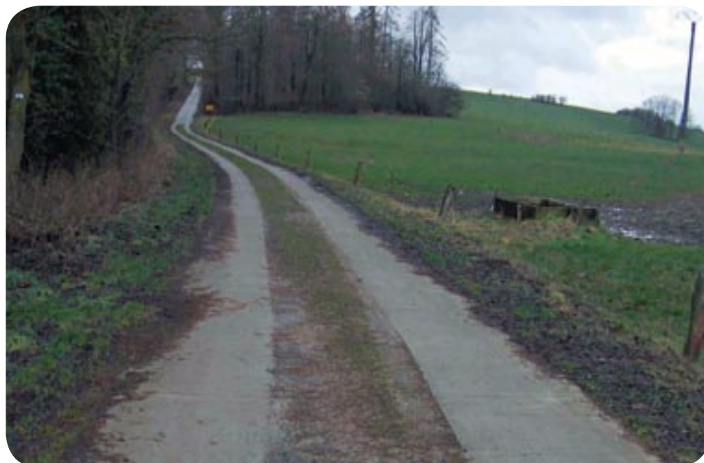
Bi-bande en béton à Falmagne
