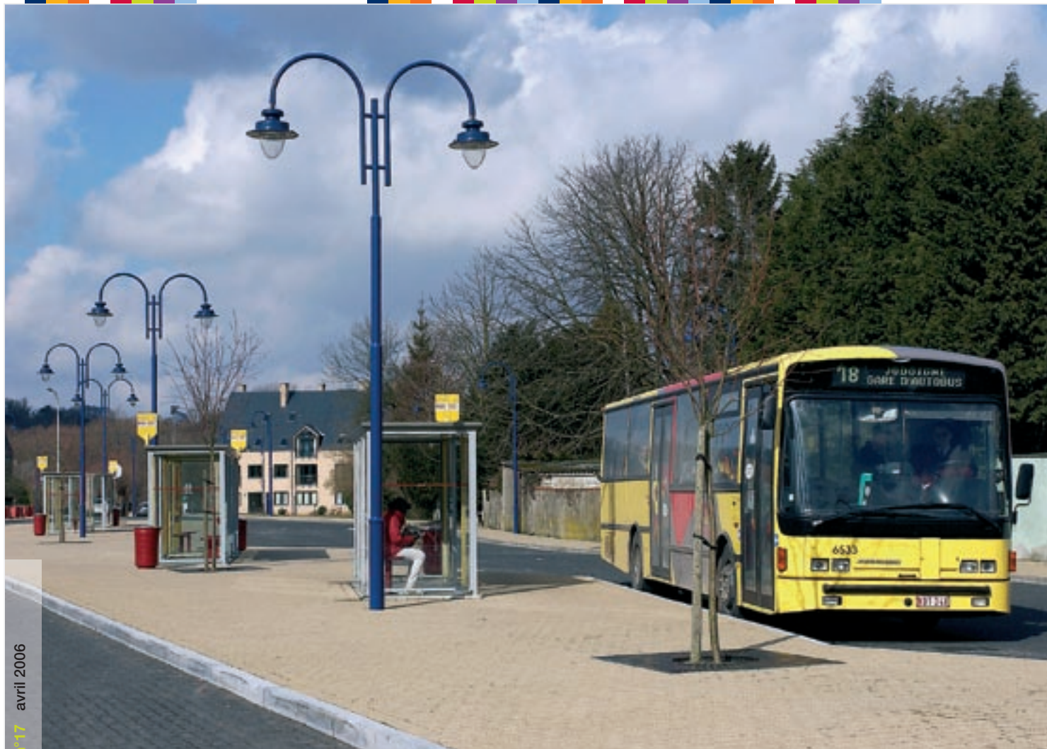
Quai central de la gare des bus à Hamme Mille. Source : SRWT.
