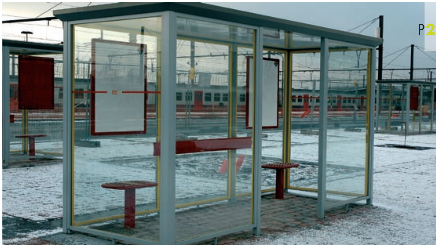
Installation de nouveaux abribus à la gare train-bus à Saint-Ghislain. Source : MET-D434.
