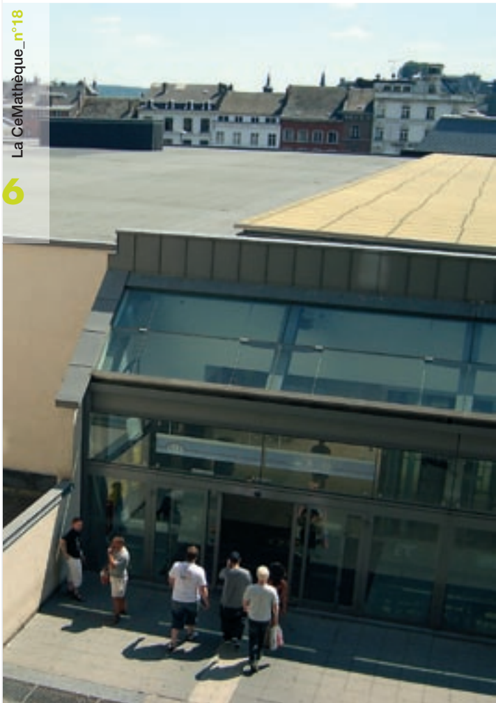
Namur : aperçu de la dalle de la gare. Source : ICEDD
