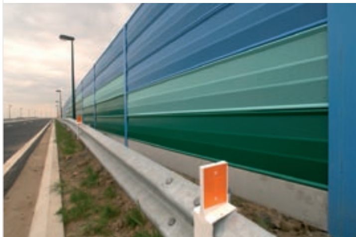
Mur anti-bruit. Source : MRW – DIRCOM – Jean-Louis Carpentier – n°4885.
