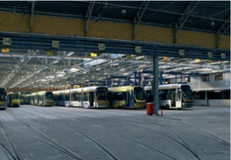
STIB : entrepôts. Source : Azariel.be.
