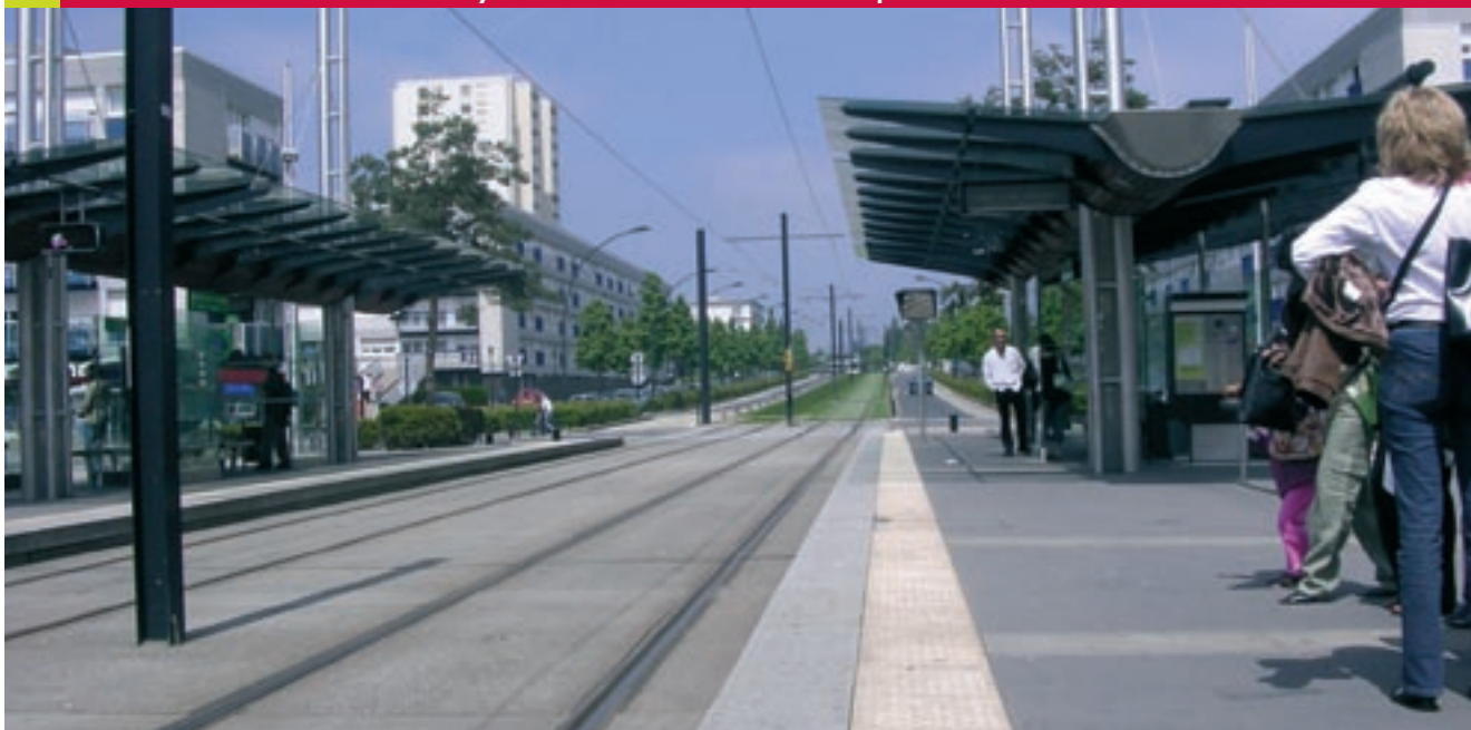
Nantes : infrastructures tram. Source : SRWT.
