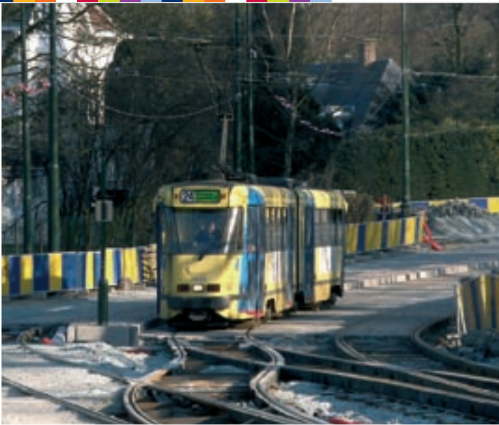
STIB : aménagement de voirie. Source : Azariel.be.
