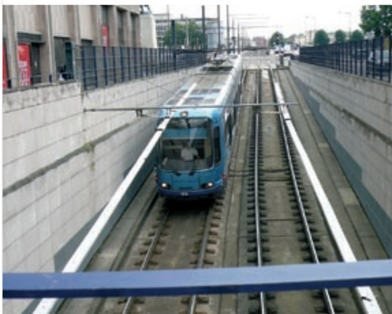
Rouen : la mise en service du tram requiert dans certains cas la mise en oeuvre d'infrastructures lourdes. Source : wikipedia.org.
