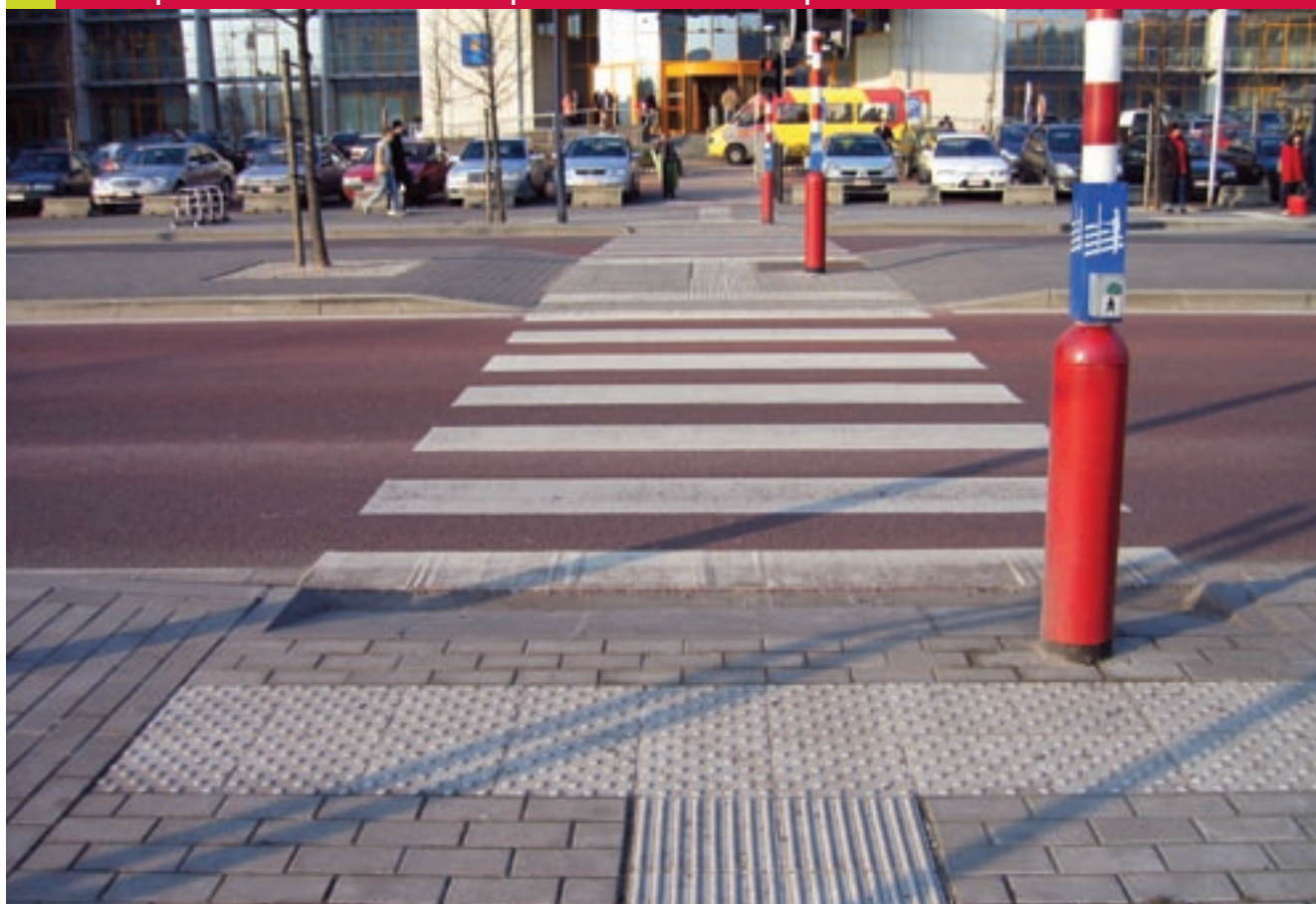
CHR Namur : aménagement et sécurisation des cheminements vélo et piéton. Source : ICEDD.
