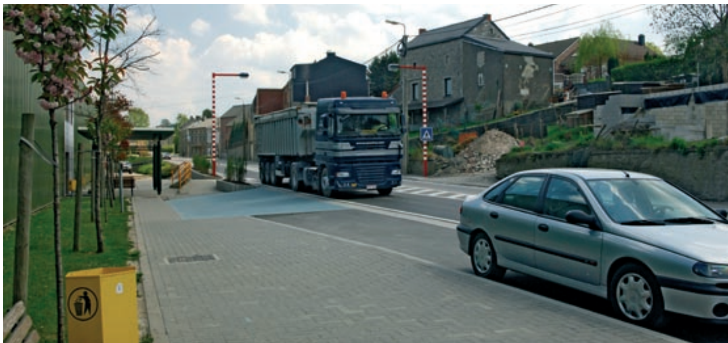
Sprimont : dévoiement et élargissement de trottoir. Source : SPW – Direction de l'Édition.
