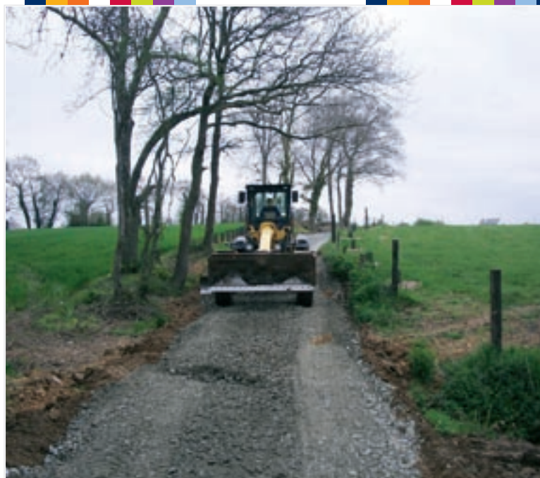
Aménagement de chemins de remembrement : revêtement empierré et double voie en béton. Sources : Remembrement-hillioninfos, PICVerts.
