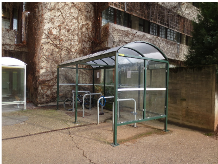
Parking visiteurs couvert et facilement accessible (CHU Liège)
