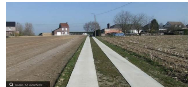
Photo 29 : Exemple de bi-bande en béton (source : SPW - Question de CeM 22)
