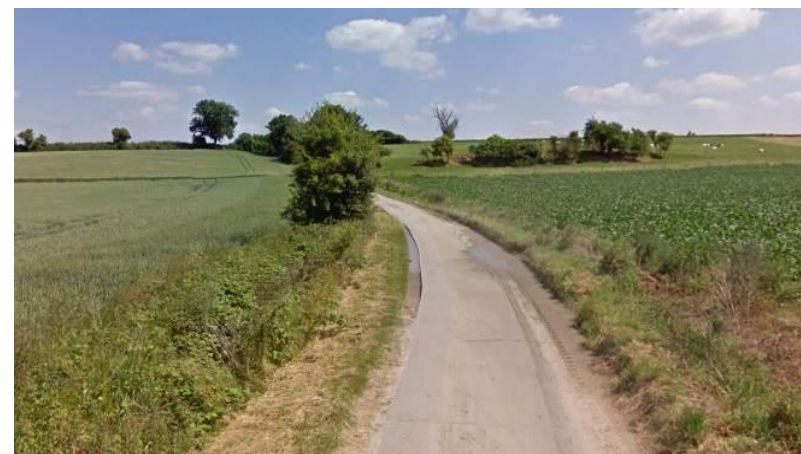
Photo 7 : Tronçon n°3 de la liaison « Vellereille-le-Sec <> Estinnes » (source : Google)
