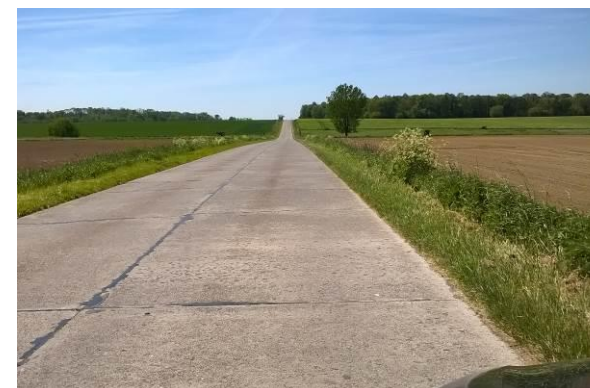
Photo 16 : Tronçon n°1 de la liaison « Vellereille-les-Brayeux <> Fauroeux »
