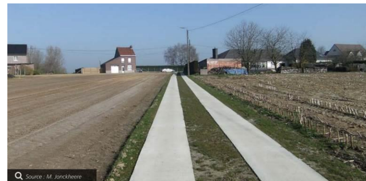
Photo 4 : Exemple de b-bande en béton (source : SPW - Question de CeM 22)
