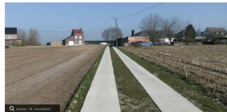
Photo 20 : Exemple de b-bande en béton (source : SPW - Question de CeM 22)
