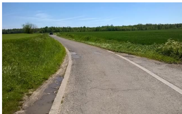
Photo 15 : Tronçon n°1 de la liaison « Vellereille-les-Brayeux <> Fauroeux »
