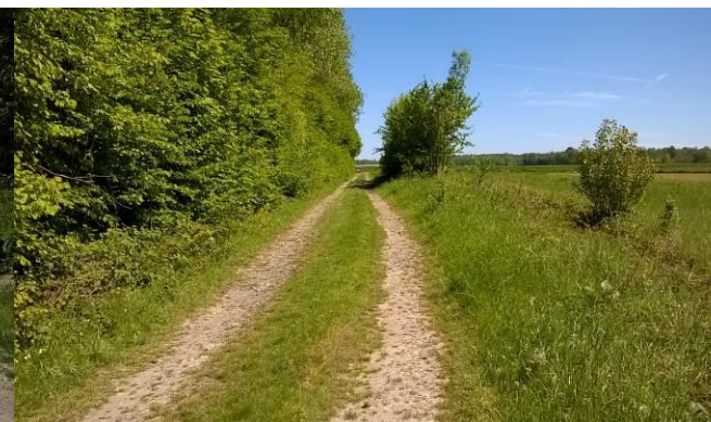
Photo 19 : Tronçon n°2 de la liaison « Vellereille-les-Brayeux <> Fauroeulx »
