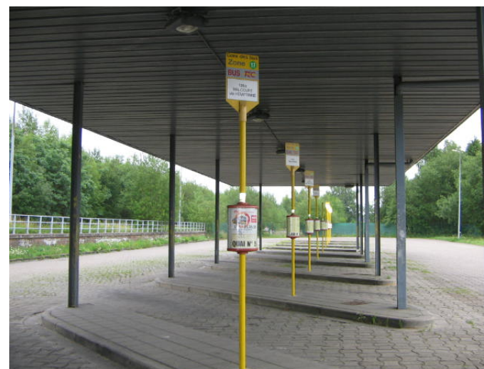
Gare des bus de Florennes
