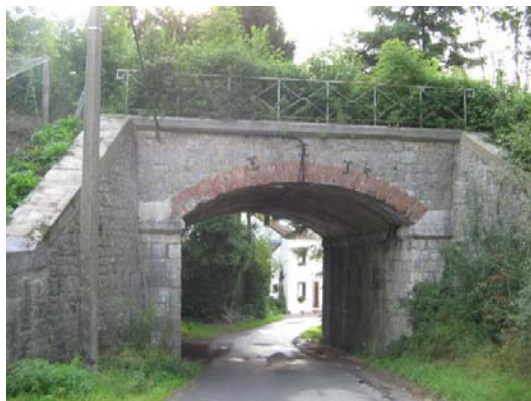
Figure 1 - Le passage sous les voies ferrées entre Florennes et Chaumont.
