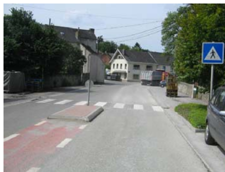
fig. Aménagement aux abords de l'institut secondaire Saint-Joseph
