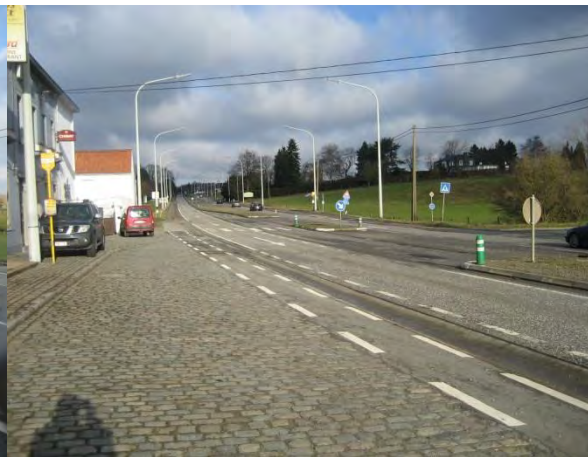
Arrêts TEC sur la N5 en amont du site
