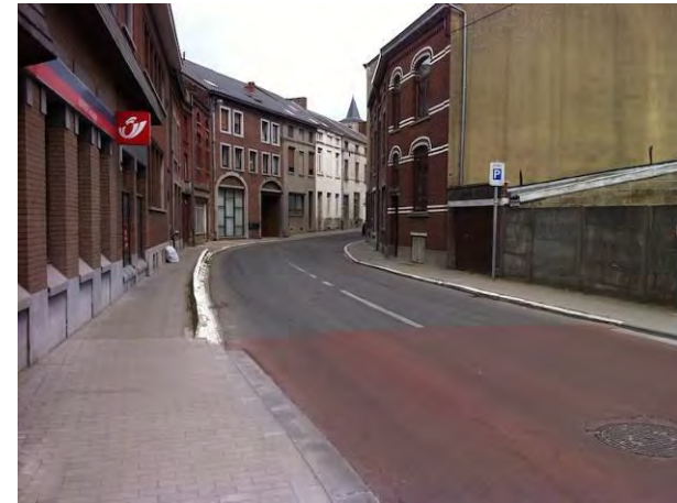
Figure 46: Vue de la rue J. Berger au centre de Genappe
