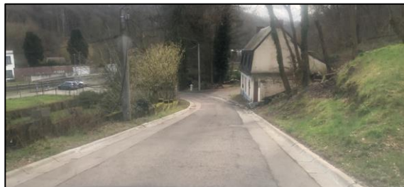
Figure 5 : Absence de trottoirs rue du Point d'Arrêt vers gare de Beignée – source : Agora
