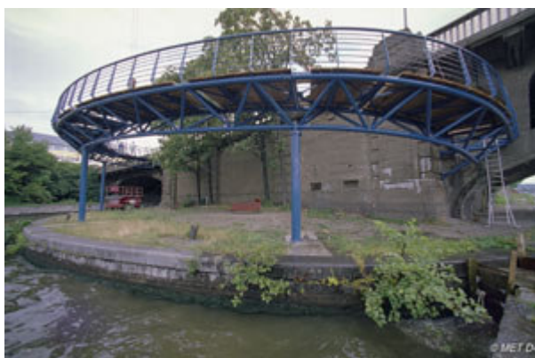
Photo 3 –Passerelle RAVeL du Pont Atlas
