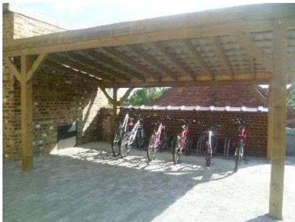
Figure 46. Range vélos à l'école communale de Mélin (Source : Ville de Jodoigne)
