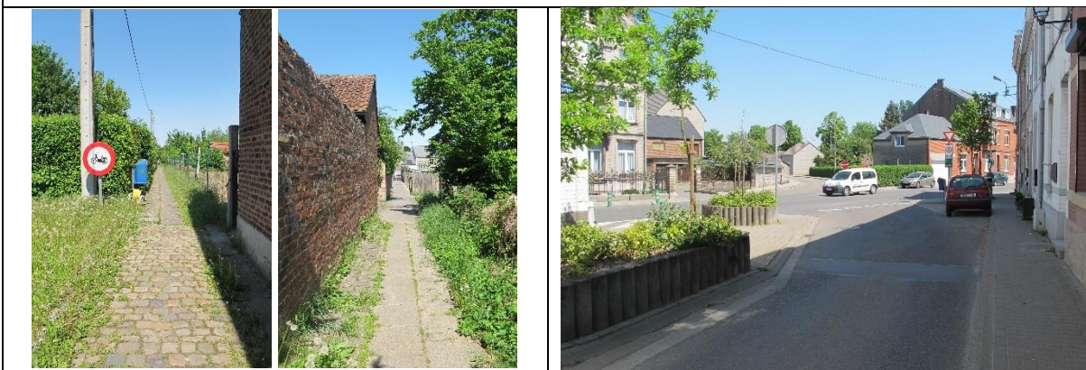
Ruelle des Gotteaux : accès à la ruelle en pavés bombés (impraticable) et problèmes d'entretien (végétation) réduisant considérablement la largeur du cheminement
