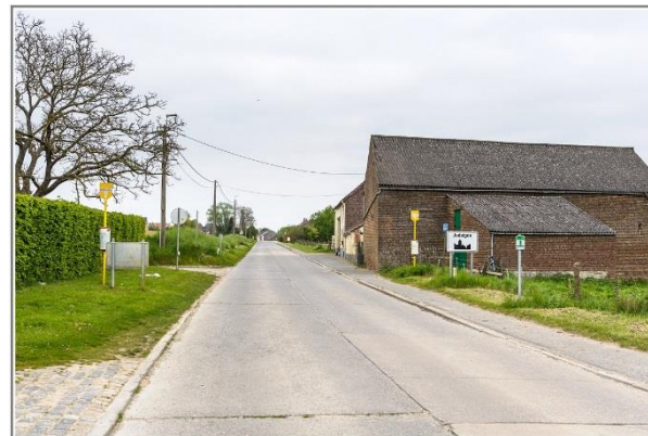
Photo 16. Jodoigne, arrêt « La Maladrerie ». L'arrêt manque d'aménagement et elle n'est pas accessible aux PMR. (Source : Agora)
