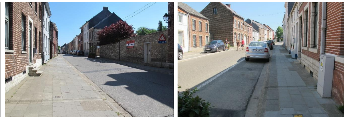
Rue du Soldat Larivière : présence de nombreux filet d'eau en demi-lune sur le trottoir pour l'évacuation des eaux de pluie des habitations
