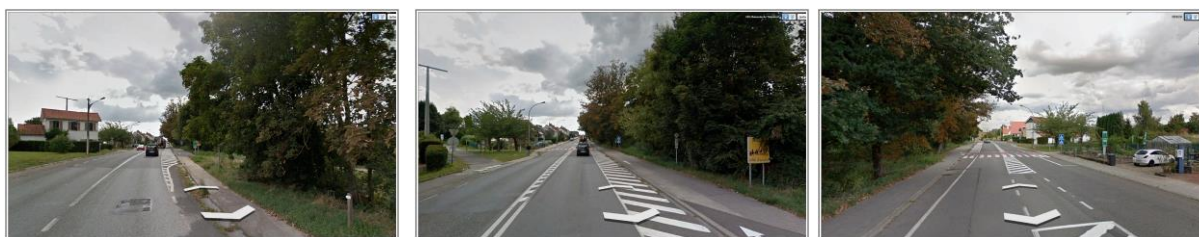
Photo 7 : vues depuis le nord et le sud sur la N29
