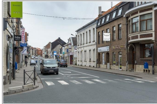
Photo 5. Jodoigne, rue du Bosquet. Traversée piétonne aménagée avec dalles de guidage et dalles d'attente. (Source : Agora)
