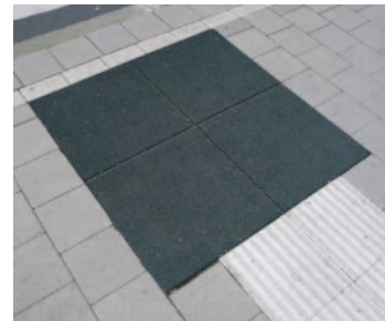
Figure 8. Revêtement en matériaux souples pour indiquer la présence d'une zone d'attente d'arrêt de bus
