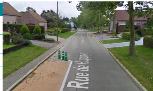
Voirie à Glimes (Incourt)
