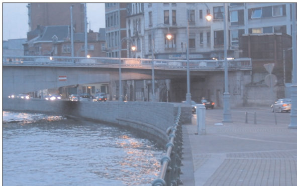
Pas d'escalier entre le pont et le quai
