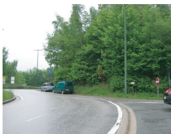
Talus autour du rond-point
