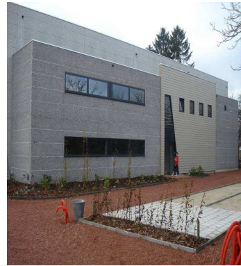
Bâtiment du Tennis Club de Feluy, les graviers rouges y sont également impraticables
