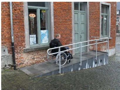
Arquennes : Maison de quartier Pente aménagée aux normes
