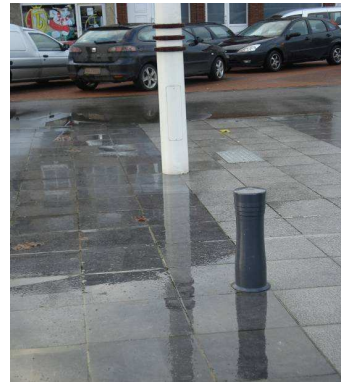
Borne trop basse, et ton sur ton, elle n'est pas visible et est donc dangereuse.
