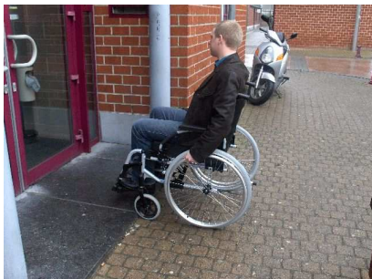
Manage: Maison de l'emploi Entrée impraticable à cause de la marche de 2 cm du seuil de pierre bleue
