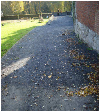
Feluy, l'accès au presbytère présente des graviers qui sont impraticables pour les PMR.
