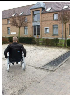
Feluy : La Ferme du Capitaine Emplacement « réservé » pour les personnes à mobilité réduite, pas aux normes
