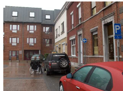
Manage: Maison de l'emploi Emplacement PMR prévu et revêtements de sol praticables
