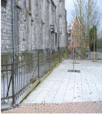
Eglise de la rue Descamps, à Manage, bel exemple de circulation aisée pour les PMR, en effet, on constate que les raccords entre les différents revêtements de sol, sont plats !
