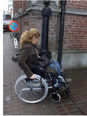
Manage: Salle Valère Motte Entrée principale impraticable, car barrée par une marche de 4cm
