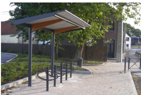
Exemple : abri-vélo à Sombrefe. Photo : Icedd
