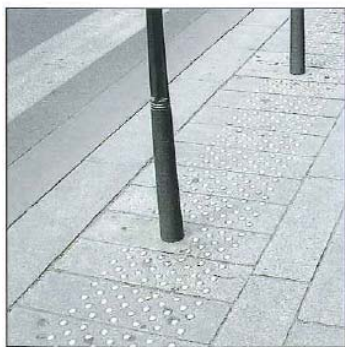
Figure 1 : les dalles de type « rivet ».
