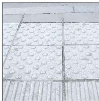
Figure 3 : les dalles de béton
