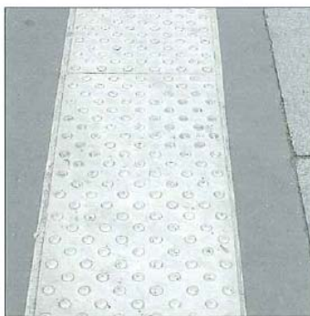
Figure 2 : les dalles collées.
