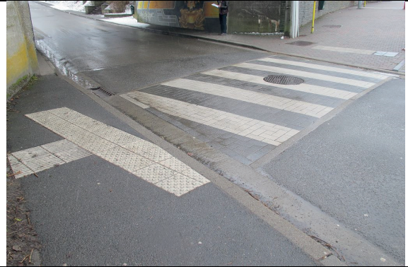
Rue de la Maison Forte : d'un seul côté ?!
