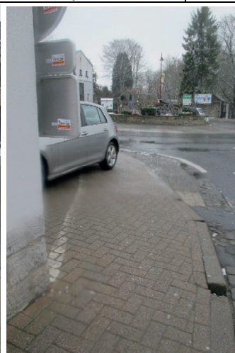
Accès aux arrêts depuis la rue de la Pépinière : libre passage trottoir insuffisant : 130 cm réduite à 90 cm à l'angle du bâtiment + stationnement.
