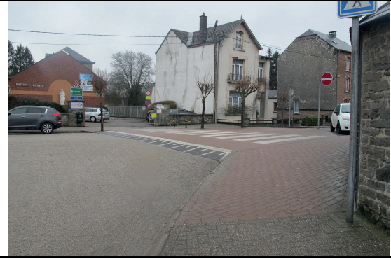
Rue des Remparts, manque dalles podotactiles
