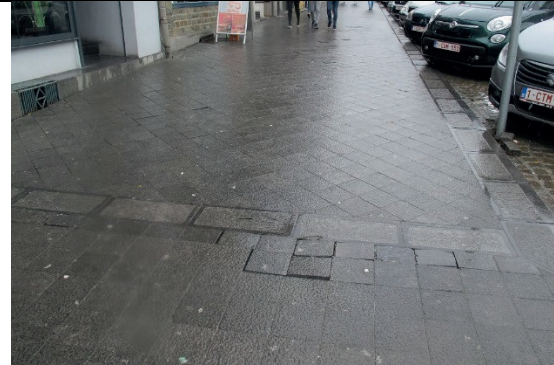
Grand-rue dégradation ponctuelle
