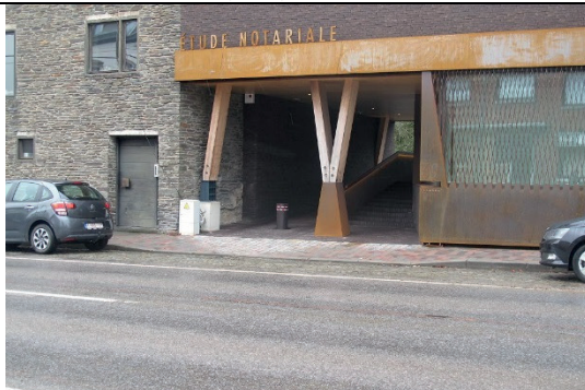
N85 Rue de Neufchâteau : aménagement pourtant récent
