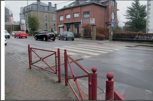
N85 Rue de Neufchâteau : bordures bateau pente excessive, absence de dalles podotactiles, trottoirs trop étroits+dévers
