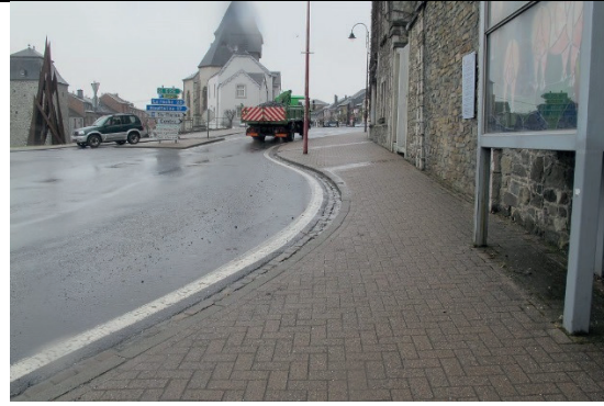
N874 Rue Gustave Delperdange (dévers de + de 5%)
