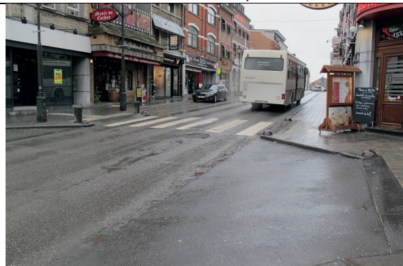
Grand-rue : bordures bateau pente excessive. Potelets dangereux. Dalles podo OK
