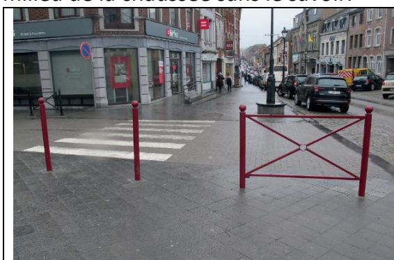
Porte de Trêves : manque dalles podotactiles
