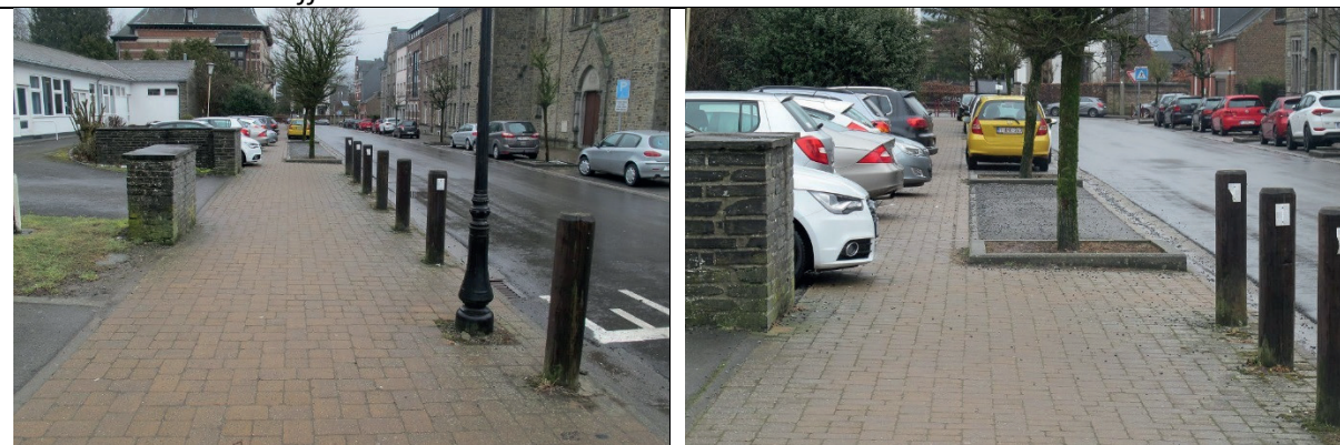
Avenue de la Gare : largeur du trottoir insuffisante + empiètement des voitures stationnées
