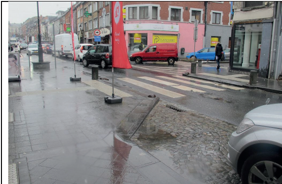
Grand-rue : bordures bateau pente excessive + ressaut au pied. Potelets dangereux. Dalles podo OK
