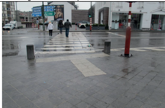
Place Mc Auliffe vers rue de Marche : traversée trop longue, bordure bateau pente excessive, bordure droite, guidage podotactile mal placé
