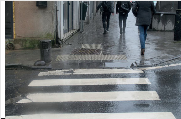
Rue de la Citadelle : guidage interrompu par taque
