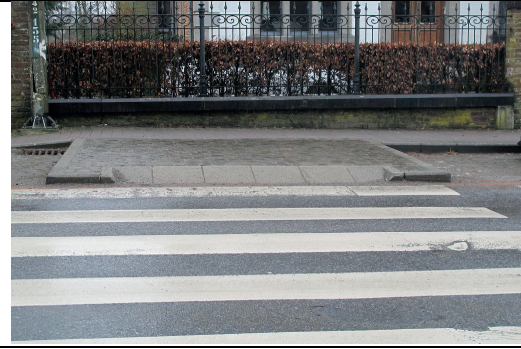
N85 Rue de Neufchâteau : bordures bateau pente excessive, absence de dalles podotactiles, trottoirs trop étroits+dévers
