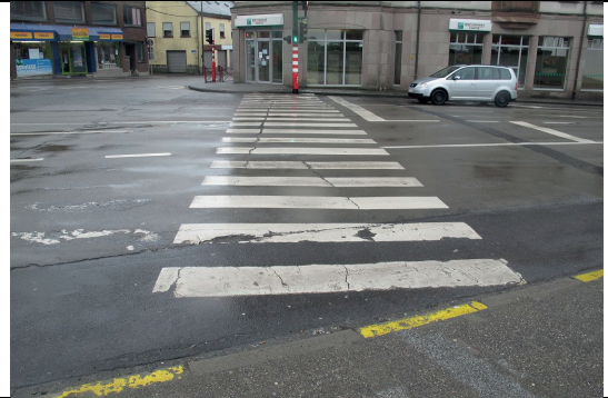
Place Mc Auliffe: traversée trop longue, bordures droites, absence de dalles podotactiles, trottoirs trop étroits et dévers
