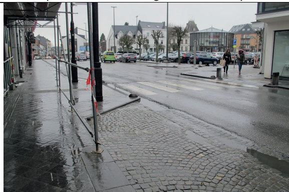
Grand-rue : bordures bateau pente excessive. Potelets dangereux. Dalles podo OK
