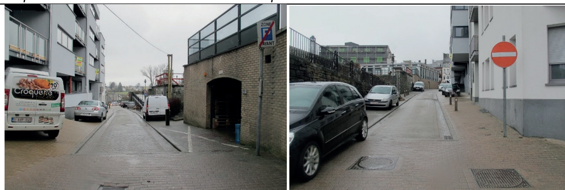
Rue Porte Haute : cette rue ne dispose d'un trottoir que d'un seul côté, celui-ci est largement impraticable car occupé par du stationnement et à plusieurs endroits en très fort dévers.
