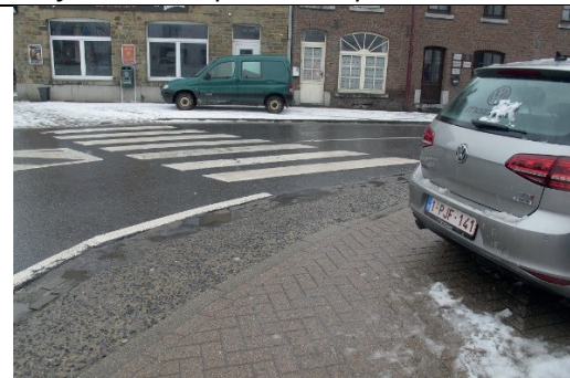
Aucune des traversées piétonnes du rond-point n'est adaptée (bordures) ni équipée de dalles pod
