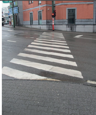
Rue Joseph-Renquin : traversée trop longue, bordures droites, absence de dalles podotactiles, trottoirs trop étroits
