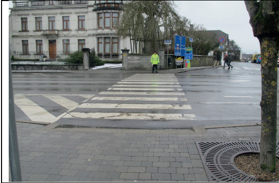
Place Mc Auliffe: traversée trop longue, bordure bateau pente excessive, bordure droite, absence de dalles podotactiles, trottoirs trop étroits
