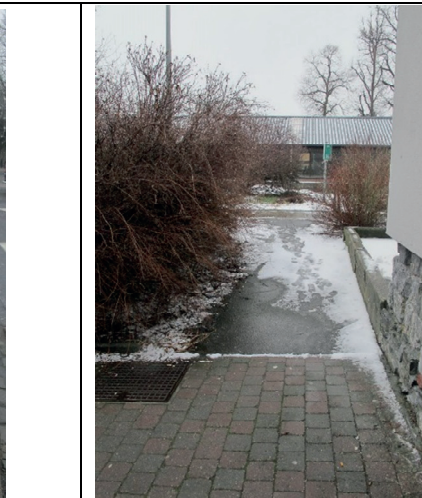
Rampe d'accès depuis Ravel : revêtement et largeur ok (attention végétation). Pente 9% (non conforme mais praticable pour certains PMR).
