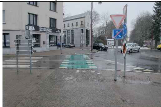
Aucune des traversées piétonnes du rond-point n'est adaptée (bordures) ni équipée de dalles pod
