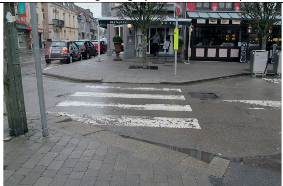
Place Mc Auliffe : bordures bateau pentes excessives + ressaut, absence de guidage podotactile
