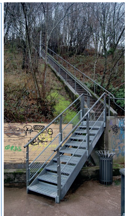
PCM de Bastogne: Réaménagement rue de Marche jusqu'à la pl. Mac Auliffe / 3
