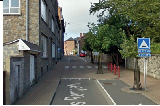
Rue des Remparts, manque dalles podotactiles
