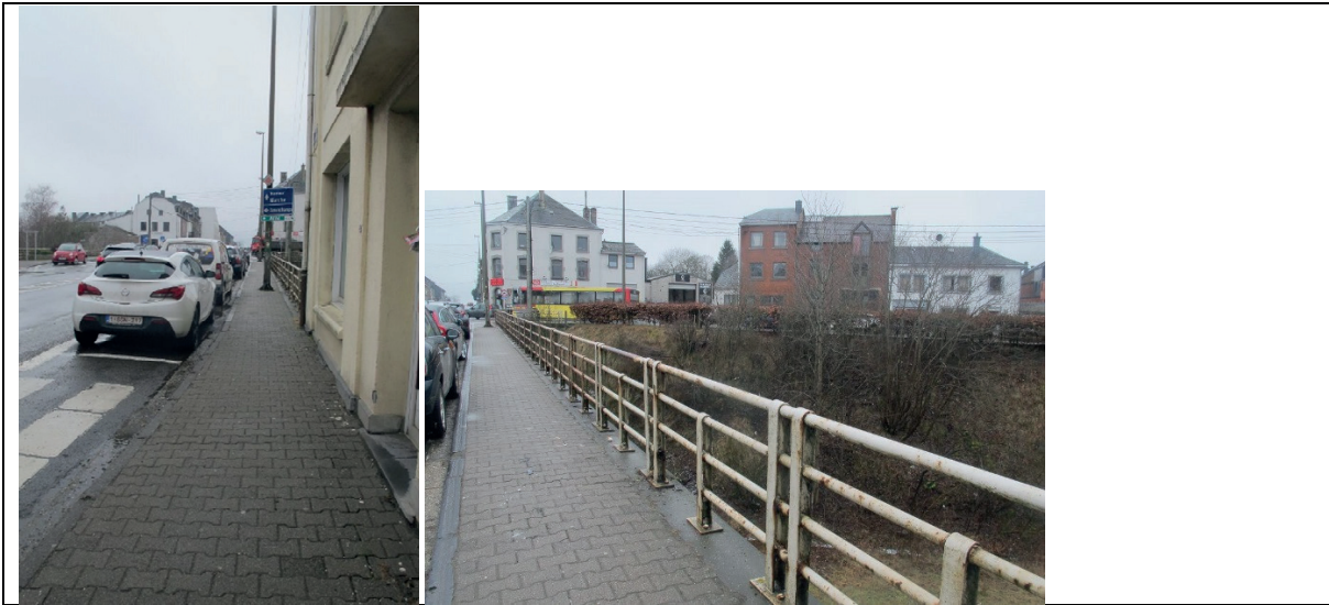
N84 rue de Marche, pont au-dessus du Ravel
