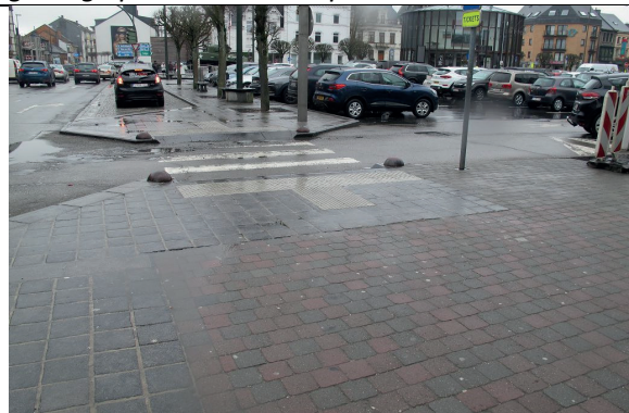
Place Mc Auliffe : bordures bateau pentes excessives, guidage podotactile trop court
