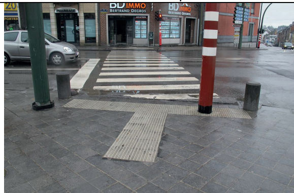
Place Mc Auliffe N30 : traversée trop longue, bordures bateau pentes excessives + ressaut, guidage podotactile mal placé
