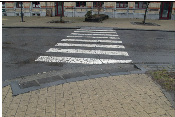
Place de la Gare : bordures bateau pente excessive, absence de dalles podotactiles
