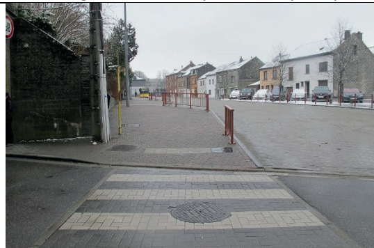
Accès depuis la rue de la maison forte difficile pour personnes en fauteuil roulant : pente 9%
