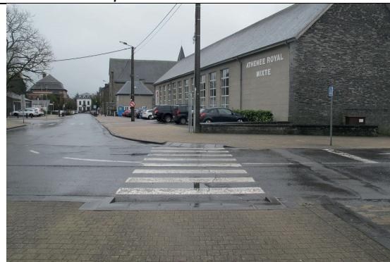
Place de la Gare : bordures bateau pente excessive, absence de dalles podotactiles
