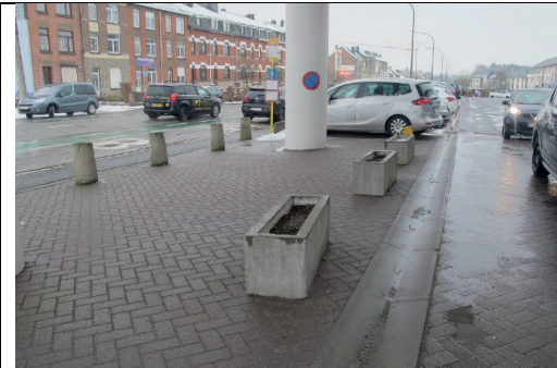
Clinique : Potelets et bacs peu contrastés et bas : ils constituent un danger pour les personnes déficientes visuelles (obstacle difficilement visible, risque de basculement par-dessus)
