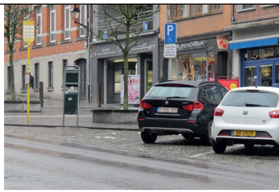
Signalisation verticale OK, largeur insuffisante
