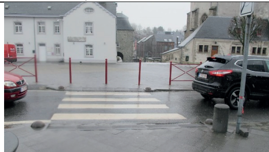
Rue Pierre Thomas : barrières et potelets rouges conformes. Potelet et boule de pierre trop ba et non contrastés.
