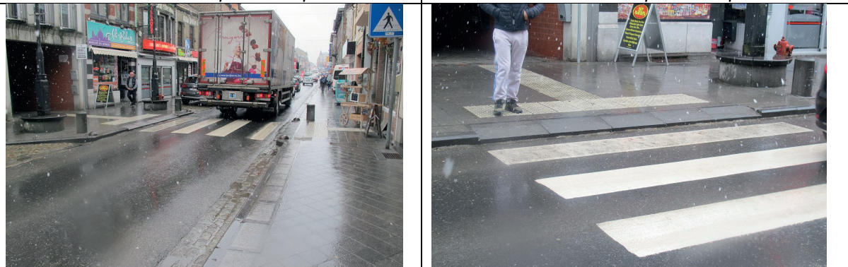
Grand-rue : bordures bateau pente excessive + ressaut au pied. Potelets dangereux. Dalles podo OK
