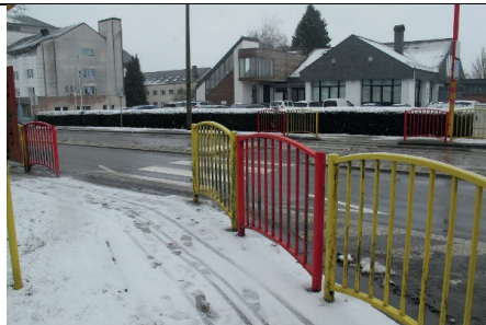
Barrières conformes le long des routes nationales. Attention toutefois au libre passage résiduel parfois insuffisant (N30 abords clinique)
