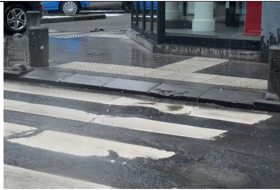
Grand-rue : bordures bateau pente excessive + ressaut au pied. Potelets dangereux. Dalles podo OK
