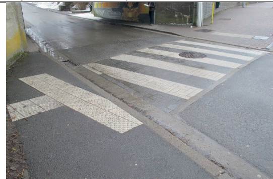
Tunnel rue de la maison forte largeur trottoir 130 cm. Traversée correcte.
