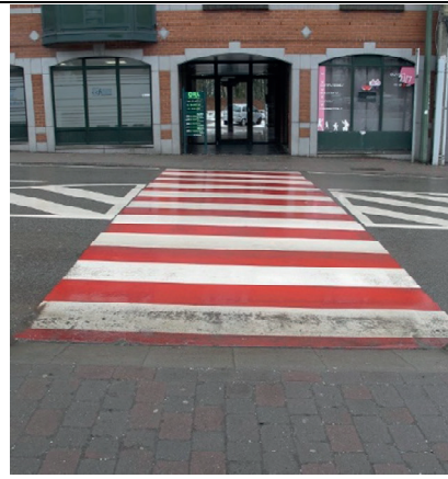
Rue Joseph-Renquin : traversée trop longue, bordure bateau pente excessive, absence de dalles podotactiles
