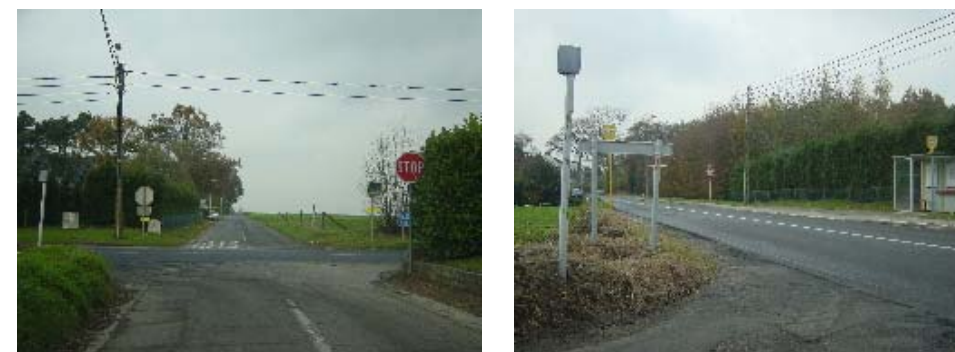
PHOTOS DE LA SITUATION EXISTANTE AU CARREFOUR TOUT VENT
