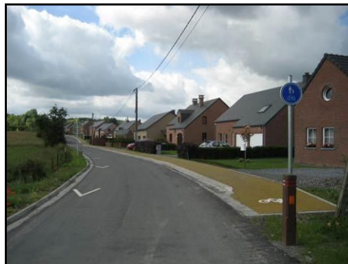
Piste unidirectionnelle dans la montée, marquage dans la descente
