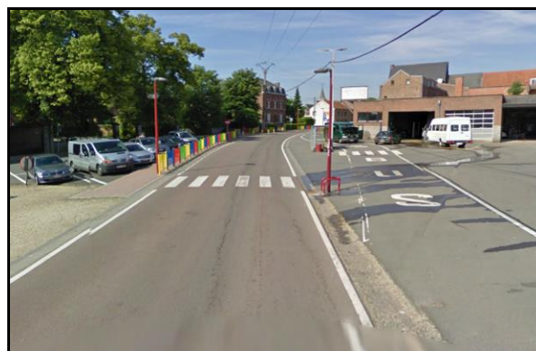
Geer, arrêt séparé de la voirie en milieu urbain
