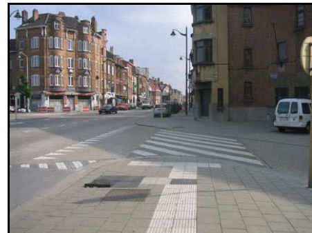
La dalle en caoutchouc indique l'arrêt de bus (position de la porte avant du bus arrêté)
