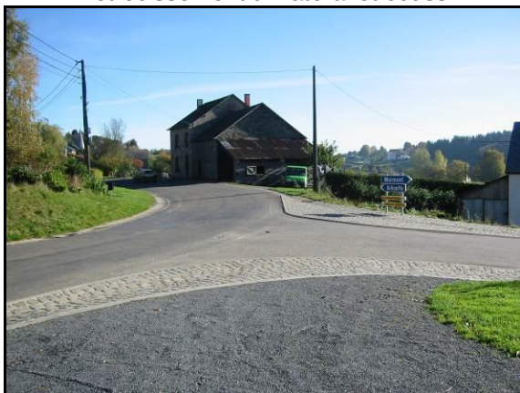
Rétrécissement au carrefour pour une meilleure sécurité et lisibilité de la route
