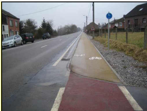
Piste cyclopiétonne bidirectionnelle, marquage rouge en traversée
