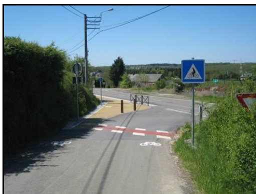
Traitement d'une traversée
