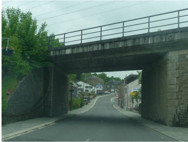
Pont voie ferrée – Bertrix
