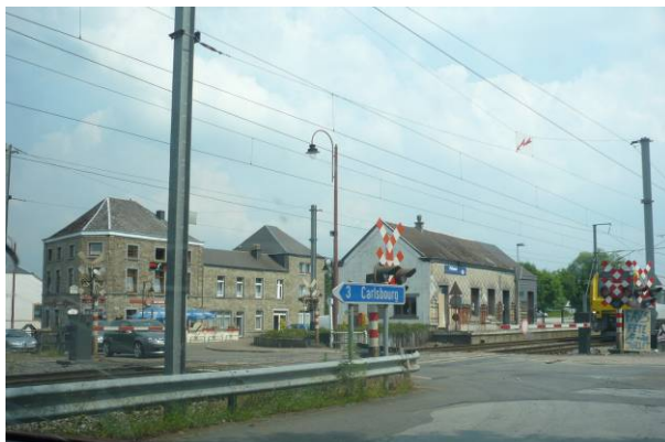
Passage à niveau – Gare de Paliseul
