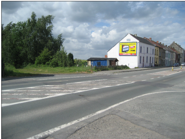
Rue de Bruxelles / RAVeL ligne 123 : • aménagement d'un îlot central.
