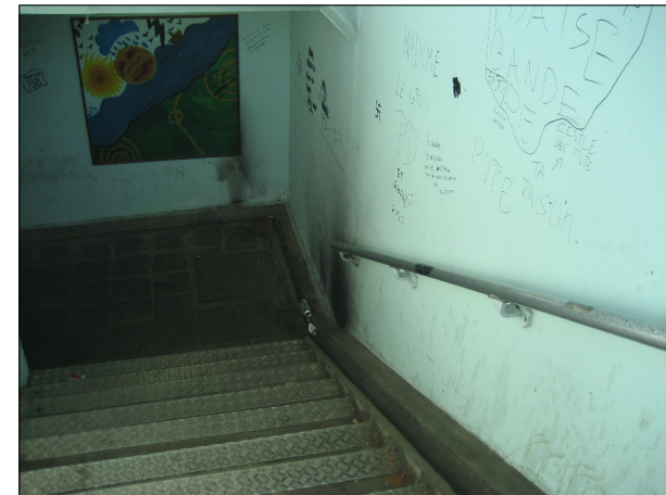
Passage souterrain rue du Moulin :
