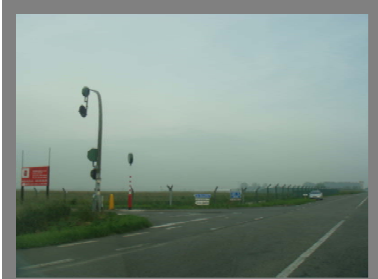
Carrefour de Bauffe : risque accidentogène élevé
