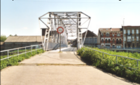
La passerelle débouchant sur le ring
