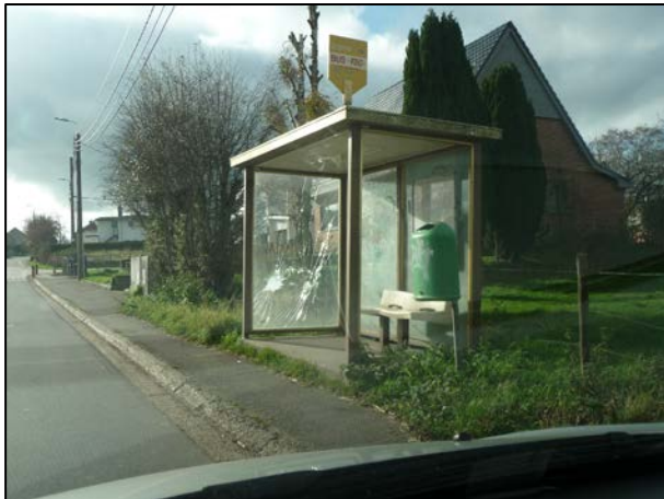
Photo 11. Abris-bus vandalisé, route de Ninane, entre Beaufays et Ninane
