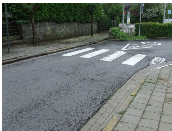
Photo 20. Absence de rampes au niveau de la traversée piétonne, rue Basse de Mehagne
