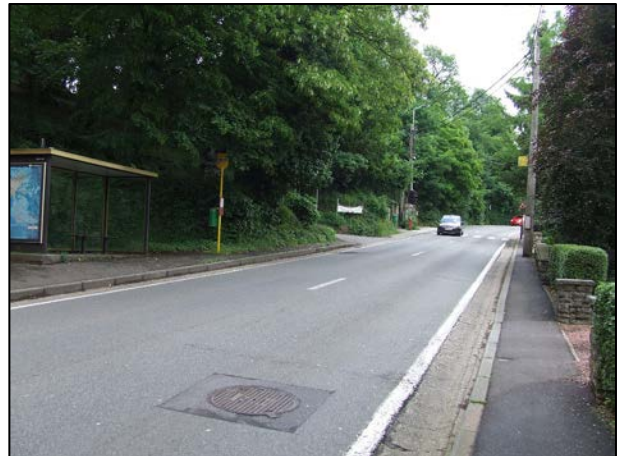
Photo 12. Arrêt desservant le collège du Sartay, rue Pierre Henvard – trottoir étroit et encombré par un poteau d'éclairage
