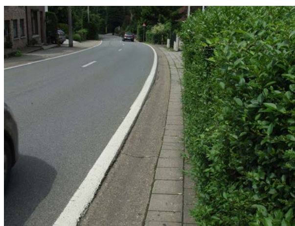
Photo 6. Trottoir étroit, rue Pierre Henvard (Embourg)
