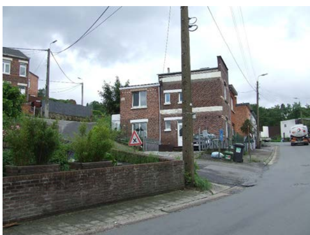
Photo 5. Trottoir étroit et revêtement en mauvais état, rue de Poperinghe (Embourg)
