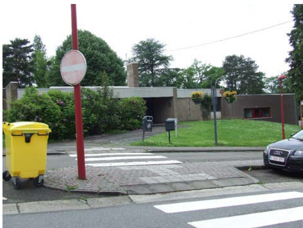
Photo 7. Exemple de traversée piétonne avec bandes de guidage podotactiles et îlot central pour personnes aveugles ou malvoyantes, avenue du Centenaire (Embourg)
