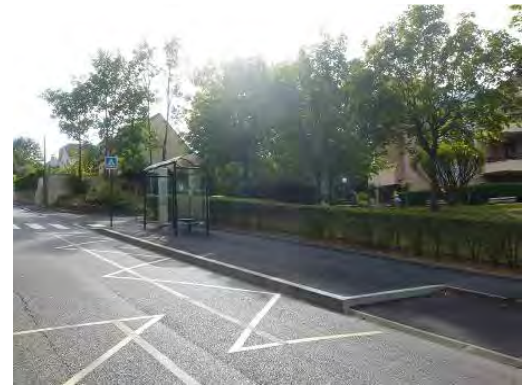
Arrêt en extension de trottoir - Pays de Limours - France
