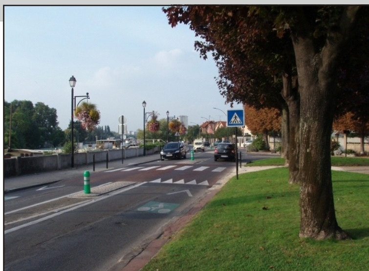
Exemple d'aménagement destiné à réduire la vitesse à proximité d'une courbe (source : Place au Vélo, Val de Marne)
