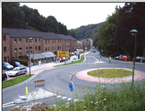
Exemple d'aménagement d'un rond-point comprenant un accès de type trottoir carrossable pour une desserte locale (source : comité de quartier Wegnez à Pepinster)
