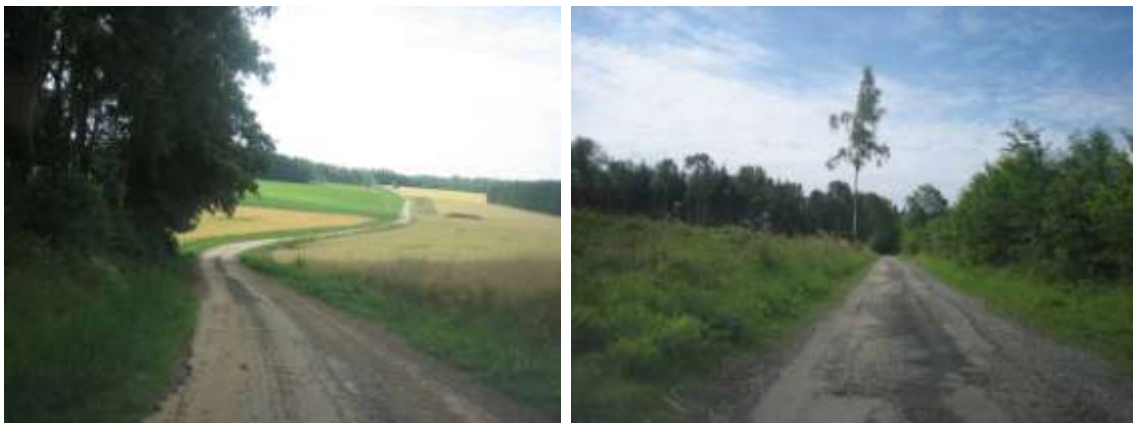
Figure 42. Exemple de voirie agricole utilisée par de nombreux automobilistes et très dégradée (route Leignon – IMP)
