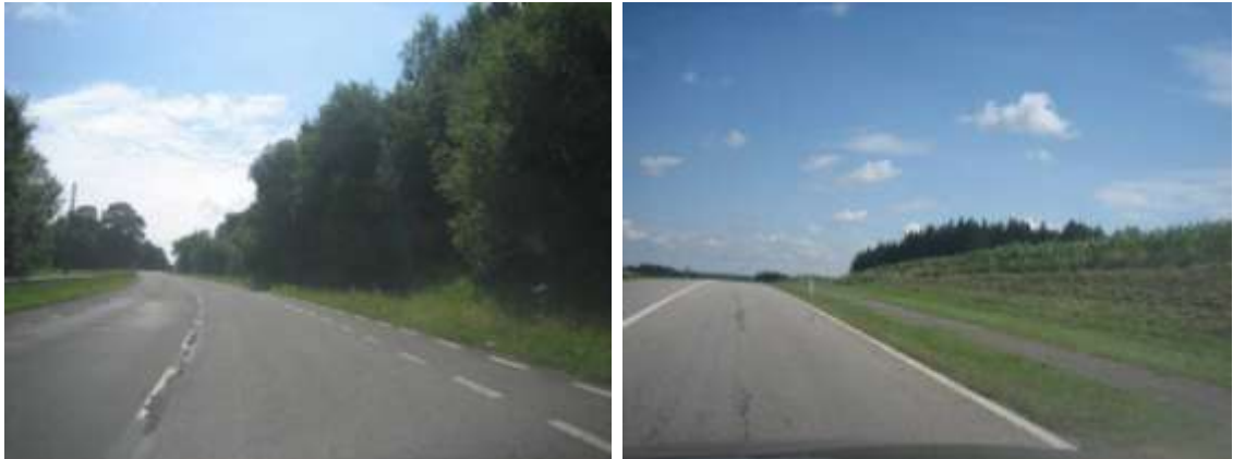
Figure 44. N949 et piste cyclable marquée (à gauche) et N929 et piste cyclable séparée (à droite)
