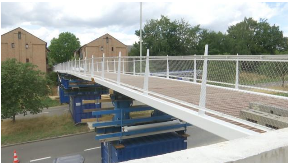
Figure 16. Exemple d'une passerelle au niveau d'un axe avec trafic dense à Louvain-la-Neuve
