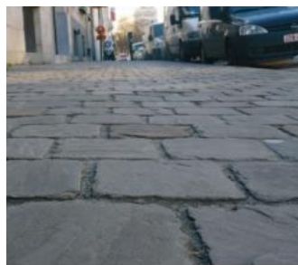
Figure 2. Revêtement en pavés de pierres naturelles
