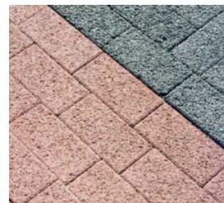
Figure 3. Revêtement drainant en pavés de béton poreux
