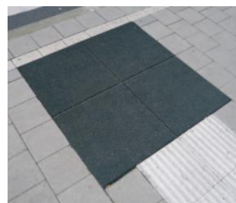
Figure 6. Revêtement en matériaux souples pour indiquer la présence d'une zone d'attente d'arrêt de bus
