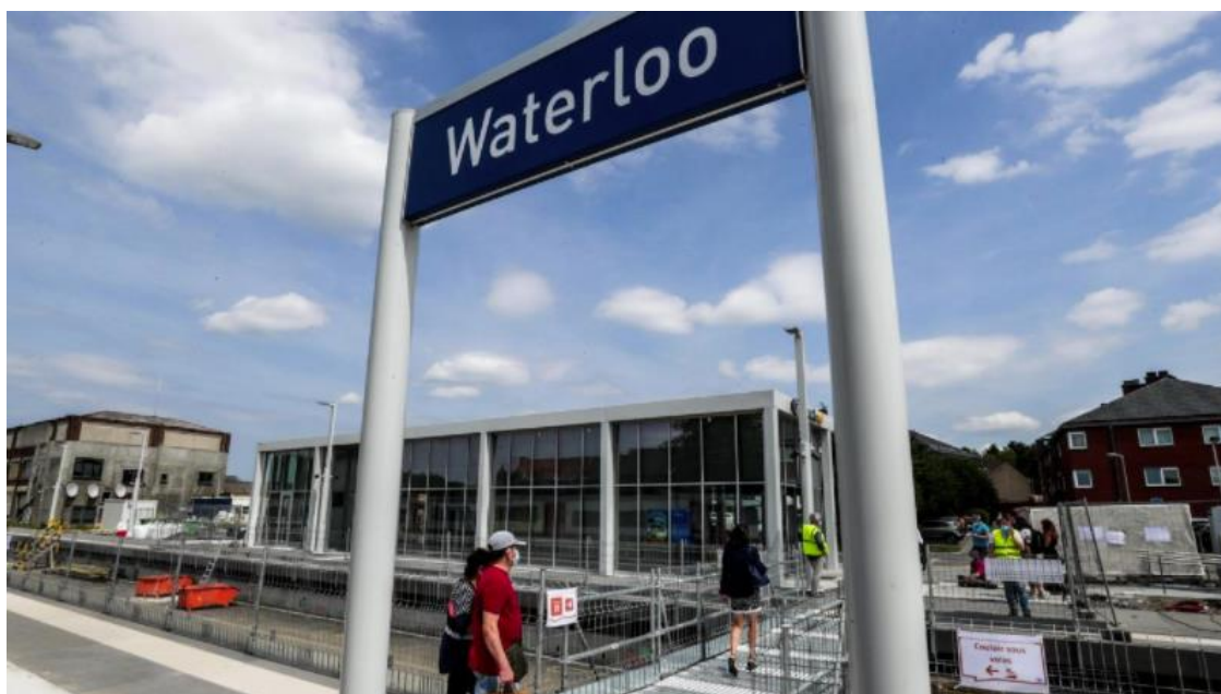
Photo 7 : nouveau bâtiment gare- prototype SNCV - source : journal Le Soir
