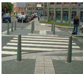
Figure 4. Dalles de guidage vers une traversée piétonne
