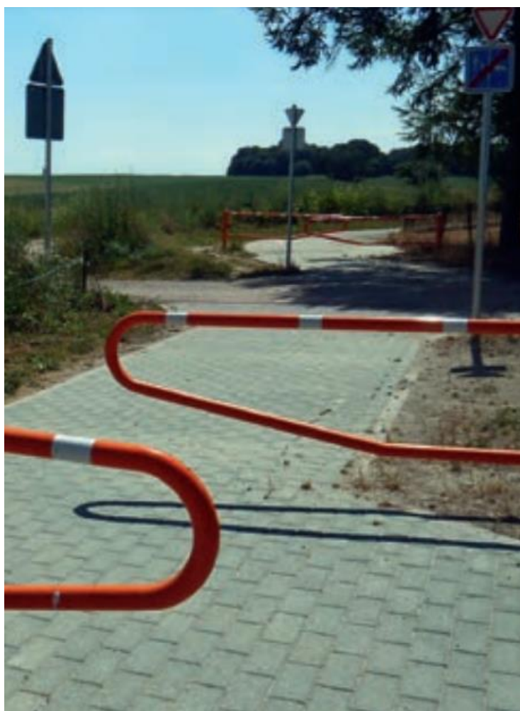
Figure 17. Exemple de chicanes pour changer la trajectoire du piéton et signaler la présence d'un danger (Source : CeMathèque n°39)
