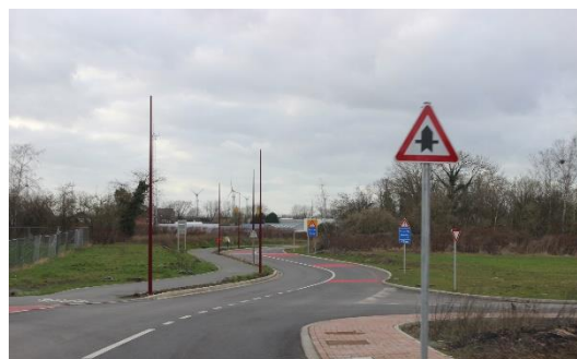
Figure 98 : tronçon du contournement de Dour (Agora, 2022)
