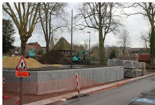
Figure 96 : travaux en cours du parc communal (Agora, 2022)
