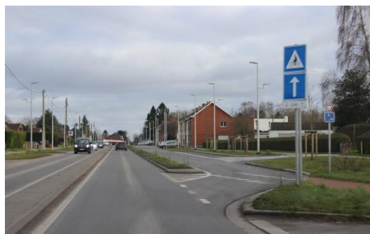
Figure 97 : tronçon de la N552 réaménagé (Agora, 2022)
