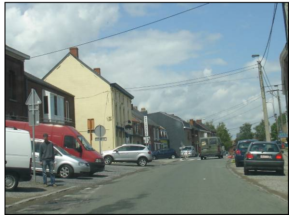
Avec les travaux, le stationnement s'organise difficilement de deux cotés de la voirie
