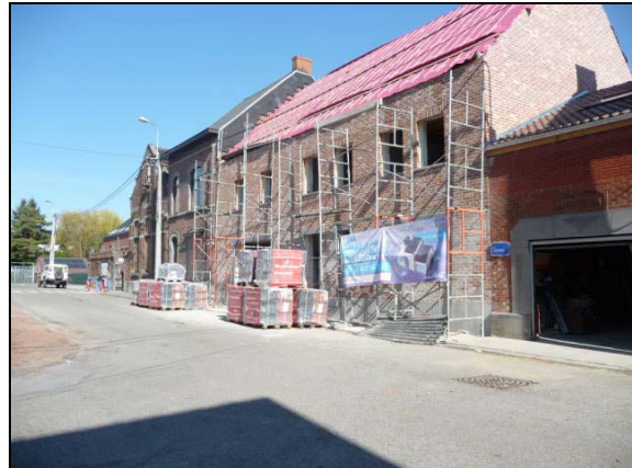
Photo 8: Vue de nouveaux logements en construction, rue de la Cure
