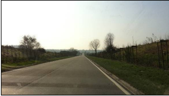
Photo 162 : accès à la N57 par la chaussée de la Résistance
