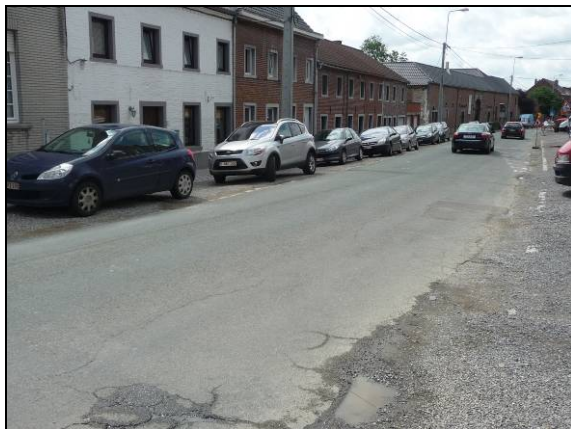
Photo 175 : stationnement sur la rue de Belle Tête
