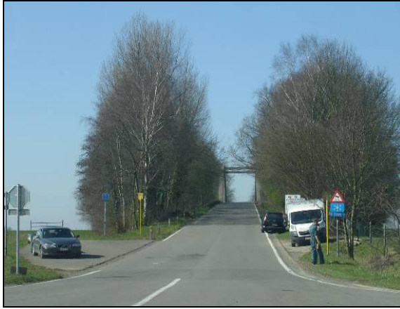
Photo 13: rue de Triboureau – croisement avec la N534 après la traversée du canal en direction de Feluy
