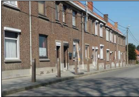
Photo 56 : potelets anti-stationnement sur la rue des carrières de l'Avedelle
