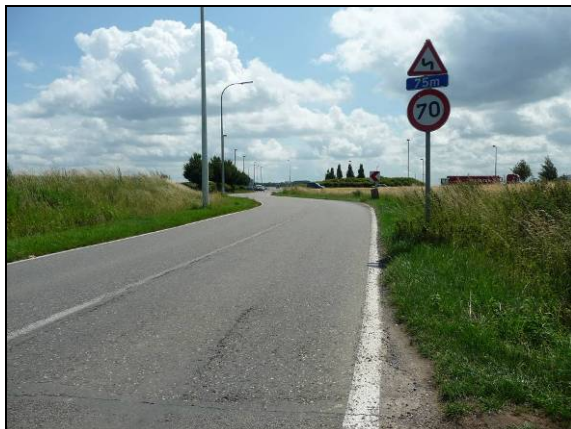
Photo 160 : accès à la N57 par la rue du Roelux
