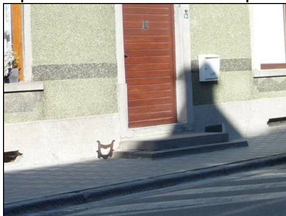
Photo 49 : trottoir réaménagé avec de la pierre bleue dans la rue Arthur Pouplier
