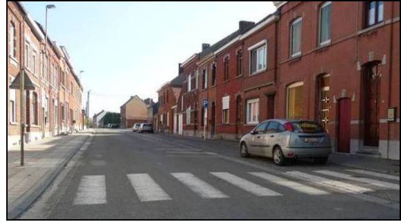
Photo 66 : trottoirs de qualité satisfaisante dans la rue de Nivelles
