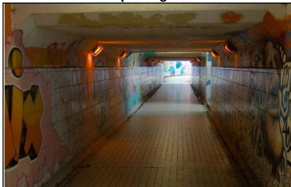
Photo 21: passage sous voie
