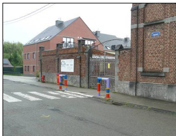
Absence d'indication de la présence d'une école et d'éclairage. Trottoir un peu étroit.
