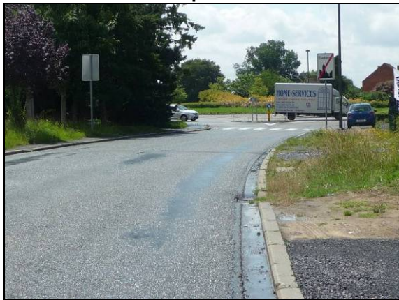
Photo 154 : accès à la N57 par la rue de Restaumont depuis Ecaussinnes
