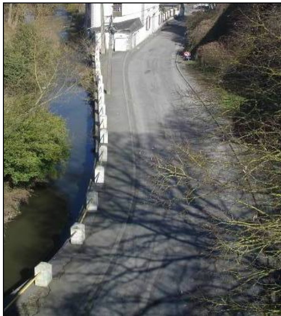
Photo 46 : trottoirs de qualité sur la rue du Moulin
