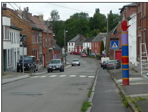
Passage piéton à signalé par un panneau Voitures garées sur les deux trottoirs Totem signalant la présence d'une école. Entrée de l'école peut visible depuis la rue. Voirie rectiligne permettant des vitesses élevées Voirie réduite par l'ajout d'une bande supplémentaire
