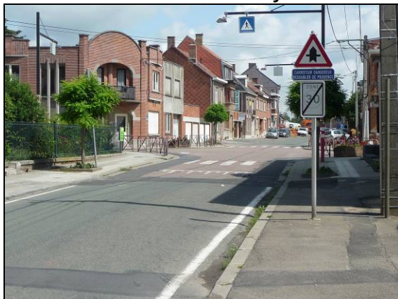
Photo 106 : arrivée sur le carrefour depuis la rue Anselme Mary
