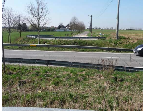
Photo 41 : rupture de la rue de la Croisette
