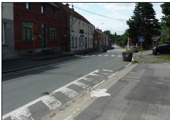
Trottoirs en mauvais états Chicane avec du marquage au sol et un bac à fleurs afin de faire ralentir les automobilistes
