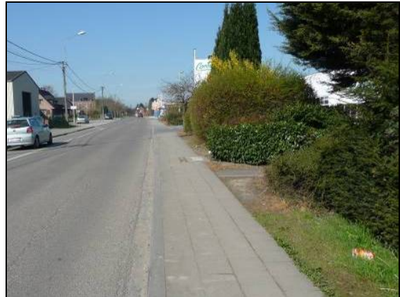
Photo 73 : trottoir étroit sur la rue de Bel Air
