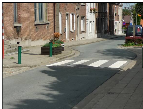
Bonne visibilité du passage piéton grâce à un marquage au sol différencié. Présence de potelets pour marquer l'emplacement. Présence également de bacs à fleurs. La voirie est aménagée pour réduire la vitesse au niveau du passage piéton (dévoisement)
