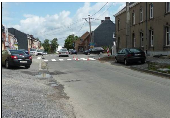
Photo 77 : arrivée sur le carrefour depuis la rue Belle-Tête
