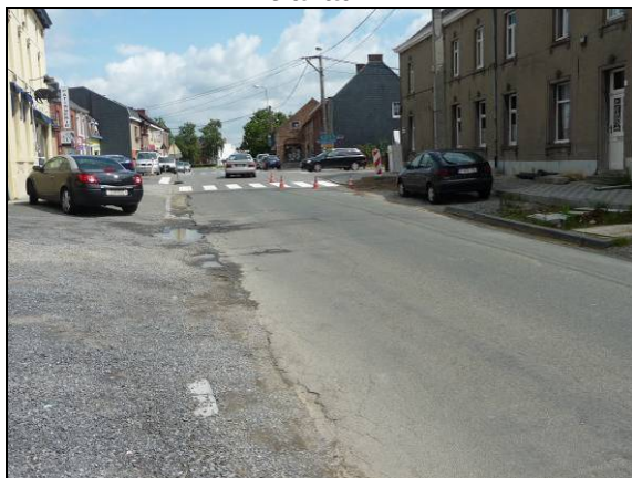
Photo 144: la N532 – rue de Belle Tête en travaux
