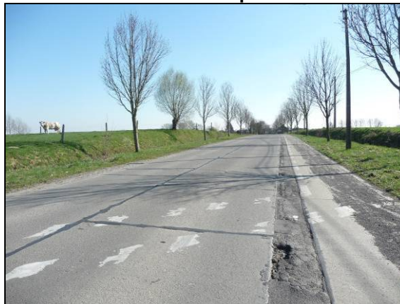
Photo 128 : traversée des cyclistes avant d'arriver au pont
