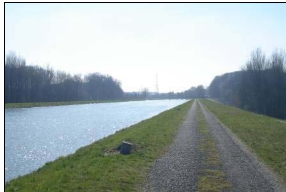
Photo 34 : vue du Canal et du RAVeL direction sud-est
