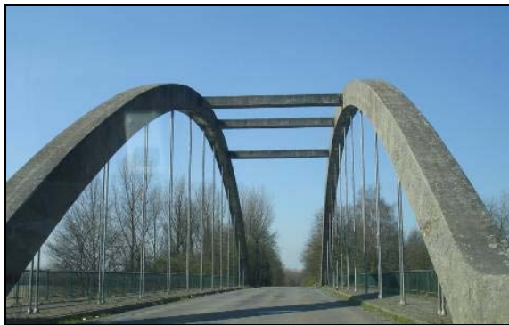
Photo 33: pont au dessus du canal – rue de Triboureau
