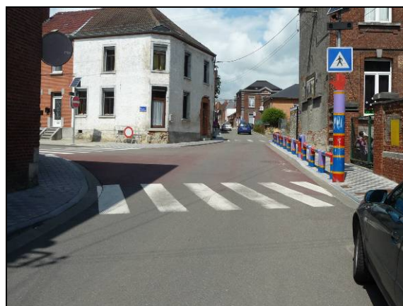
Voirie en sens unique Totem et barrières de couleurs pour marquer l'école Passage piéton signalé par un panneau Marquage au sol rouge estompé Absence d'éclairage au niveau du passage piéton
