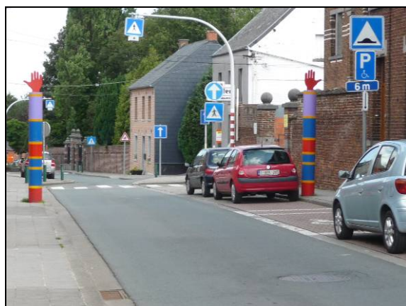
2 Un passage piéton est bien signalé par des totems et feux clignotants Présence d'une place PMR bien indiquée
