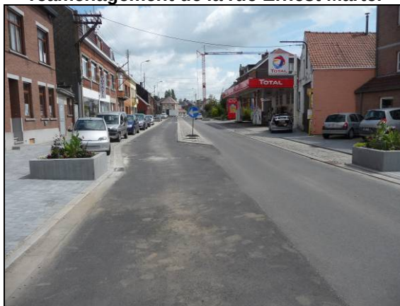
Photo 132 : absence d'aménagement lors du réaménagement de la rue Ernest Martel
