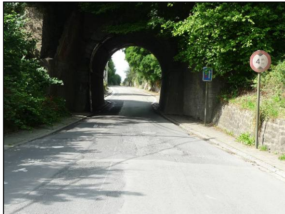
Photo 100 : passage de la rue Vandervelde sous la voie ferrée
