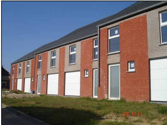
Photo 7 vue des nouveaux logements au début de la rue de la Croisette, vers la N532
