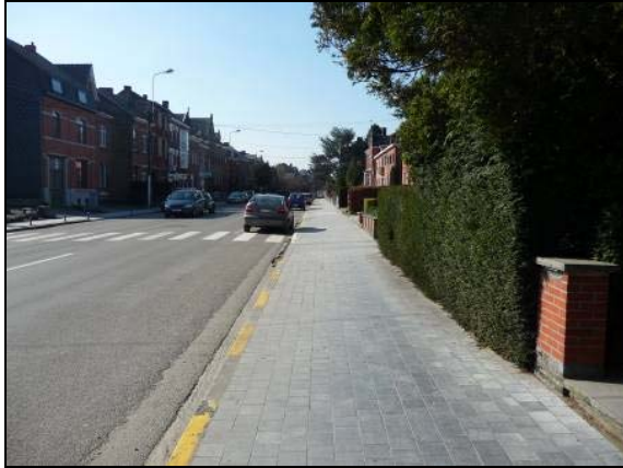
Photo 65 : trottoir avec une largeur importante dans la rue Ernest Martel
