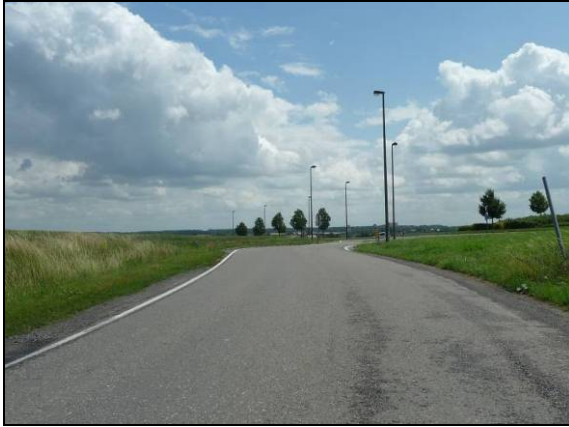
Photo 156 : accès à la N57 par la rue Mary depuis Ecaussinnes
