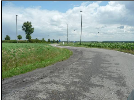
Photo 159 : accès à la N57 par la rue du Roelux
