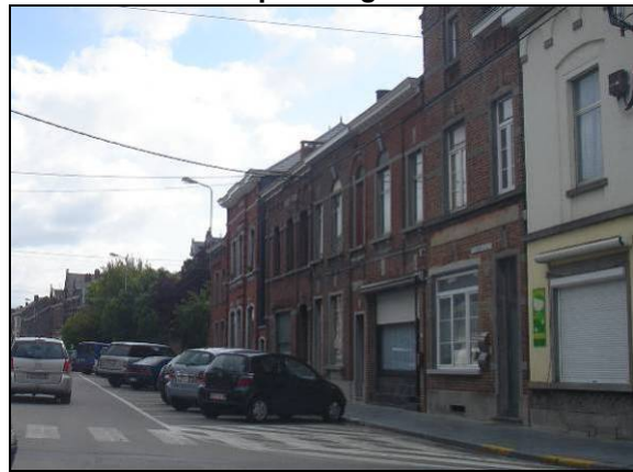
Photo 149 : avenue de la Déportation- accès depuis la gare
