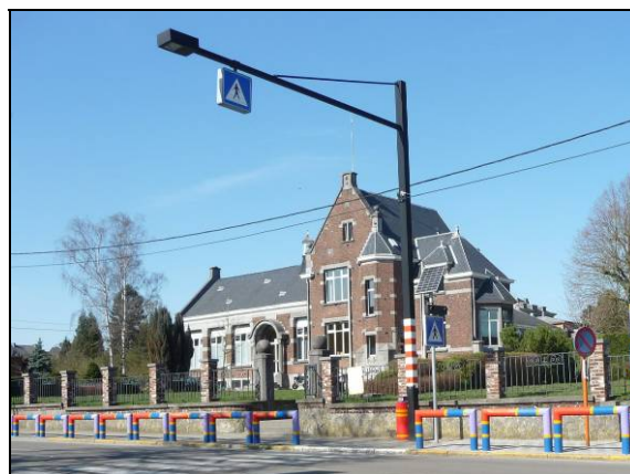
Eclairage du passage piétons
