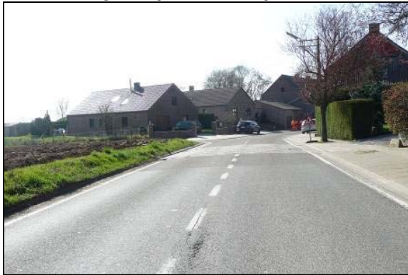
Photo 42 : entrée dans Ecaussinnes-d'Enghien par la N532 par le sud
