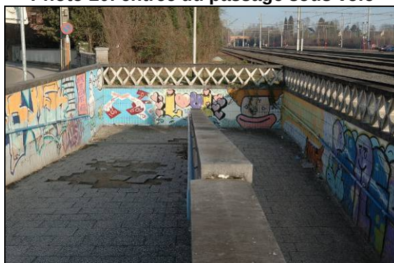
Photo 20: entrée du passage sous voie
