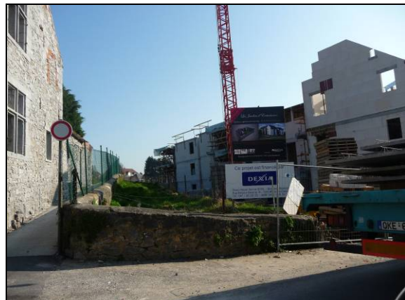
Photo 6 : vue de logements en constructions, rue du Daim
