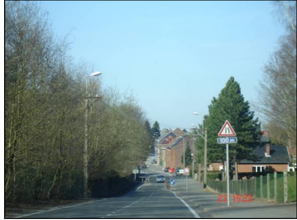
Photo 71 : trottoir d'un seul côté au niveau des premières habitations sur la rue Anselme Mary
