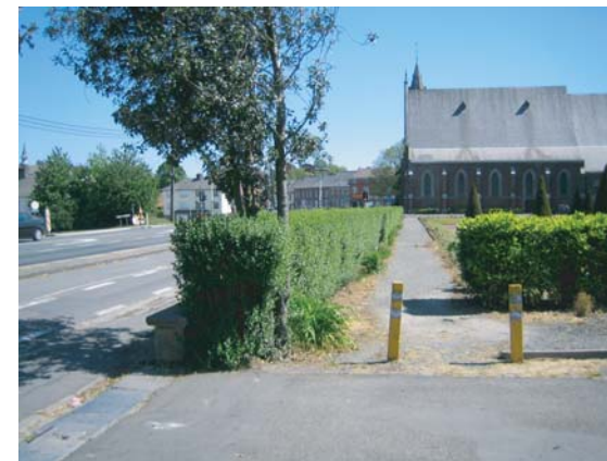
Pavé d'Ath, Collège Saint-Augustin. Des solutions pour le stationnement et l'embarquement des bus scolaires existent peut-être à l'intérieur de l'enceinte de l'établissement.
