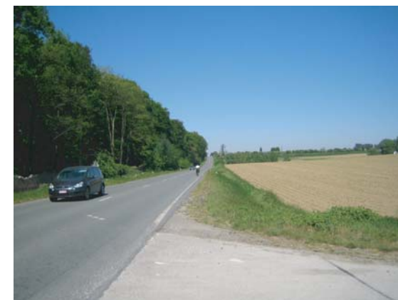
Chaussée de Brunehaut. Un exemple de voirie de faible gabarit appropriée pour les cyclistes mais la chaussée dans laquelle elle débouche n'est pas équipée.
