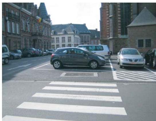
Place Delannoy. Les cheminements piétons manquent actuellement de cohérence, la logique d'organisation étant conditionnée par les emplacements de stationnement.
