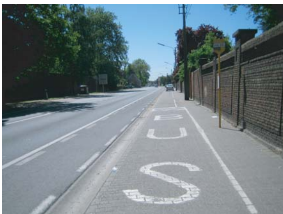
Chaussée Soignies (collège St-Augustin). L'espace d'attente des écoliers est insuffisant et peu sécurisé.
