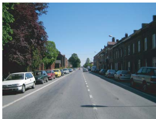
Chaussée de Bruxelles, à proximité de la polyclinique (en direction de Petit Enghien). Cette portion de la chaussée est le chaînon manquant entre le centre d'Enghien et le reste de la chaussée.
