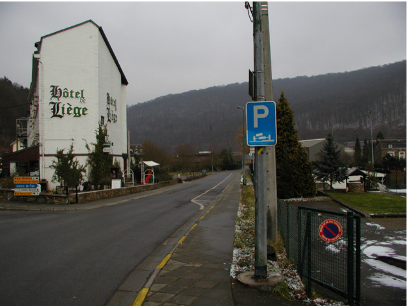
La largeur de la chaussée étant de 5.60 m, une mise en sens unique devra être envisagée.
