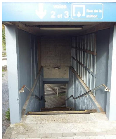
Figure 93: Escalier permettant de rejoindre la gare au quai numéro 2 (photo Tractebel)
