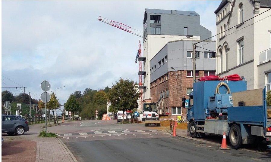
Figure 85: Photo de l'ancien silo à grains en cours de transformation (prise le 13 octobre 2017, Tractebel)
