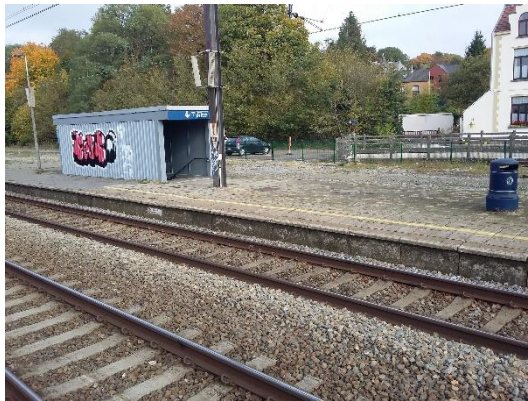
Figure 92: Aménagement du quai numéro 2 (photo Tractebel)
