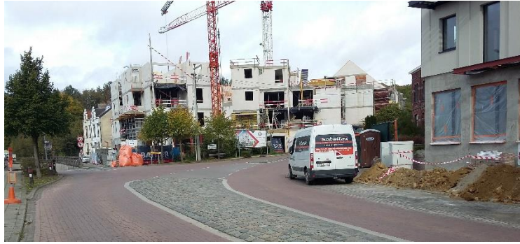
Figure 83: Photo projet Cérès en cours de construction (prise le 13 octobre 2017, Tractebel)
