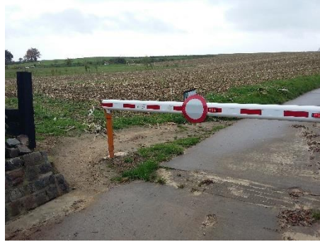
Figure 21: Barrières située chemin du Tollet (photo Tractebel)
