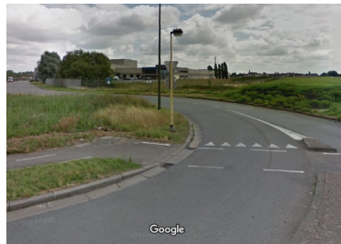
PCS du rond-point du boulevard de l'Eurozone
