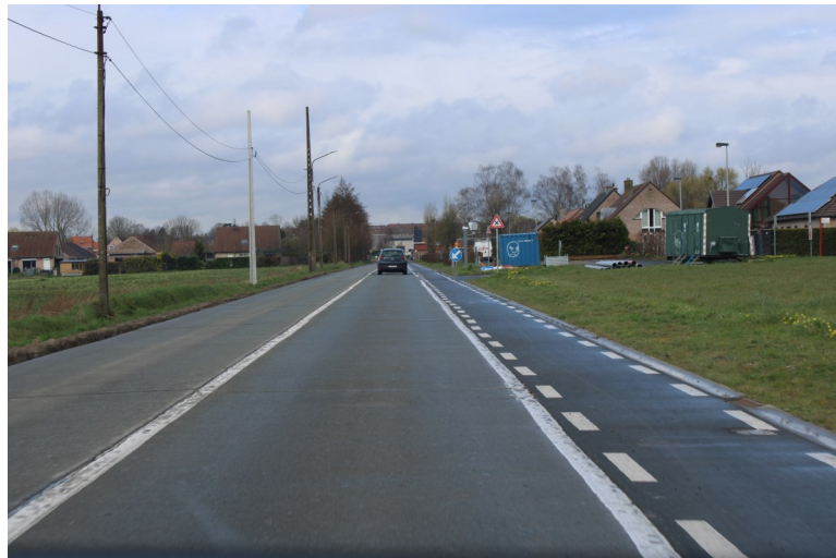
Rue de la Barrière de Fer
