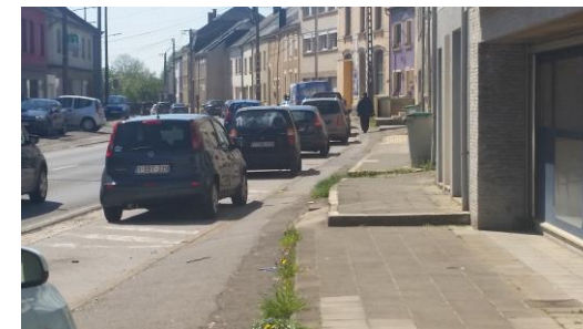
N88 côté Nord : trottoirs inaccessibles
