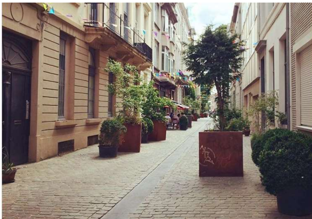
Figure 2 : Rue Keyenveld à Ixelles – Trois rues sont réaménagées en "zone de rencontre" : la vitesse des véhicules est limitée à 20 km/h, les piétons sont prioritaires, le revêtement est constitué de pavés gris plats, sur un seul niveau (sans trottoirs), de façade à façade, avec une légère déclivité centrale. Photo : Tractebel 2017
