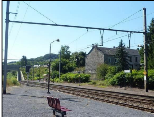
Photo 20 : Quais bas à Forrières
