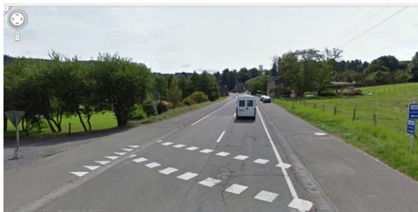
Traversée de la N833
