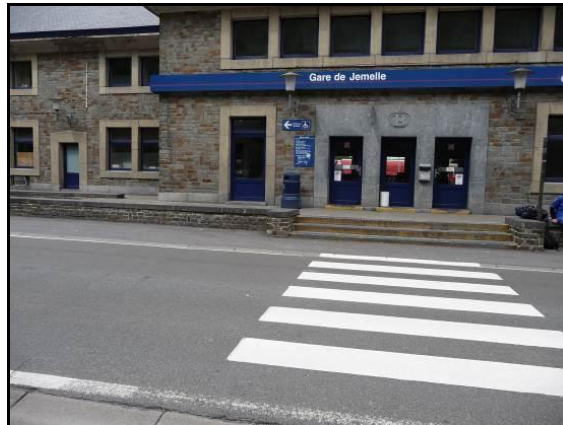
Photo 17 : Bâtiment voyageur de Jemelle
