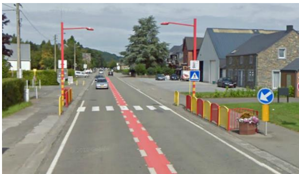
Traversée aménagée pour l'école
