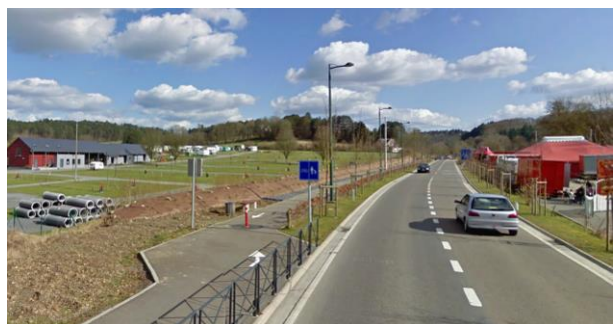
Pise cyclopiétonne vers la N86
