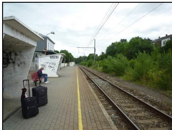
Photo 12 : Abris voyageurs en béton
