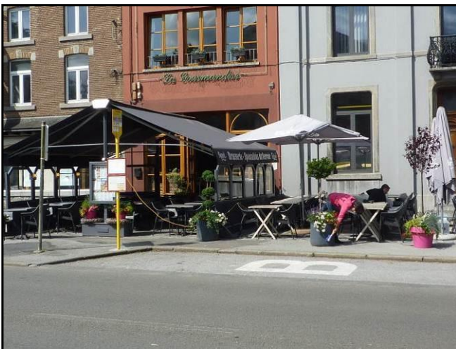
Exemple : arrêt de bus à aménager à Rochefort pour les PMR Il manque la présence d'un quai surélevé - complété d'un cheminement adapté et sécurisé jusqu'à l'arrêt. Aussi, le trottoir est très encombré, ce qui le rend peu accessible.
