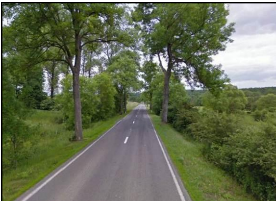
Section située entre la N63 et la N4. Le profil est en 2x1 voie avec accotements enherbés.
