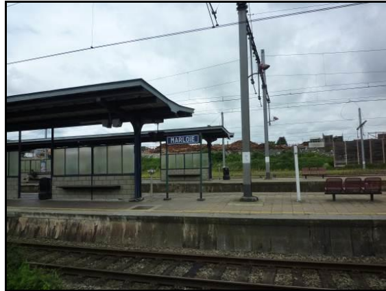
Photo 16 : Abris voyageurs à Marloie
