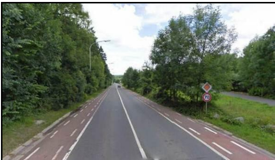
Route de Marche, sortie de Rochefort
