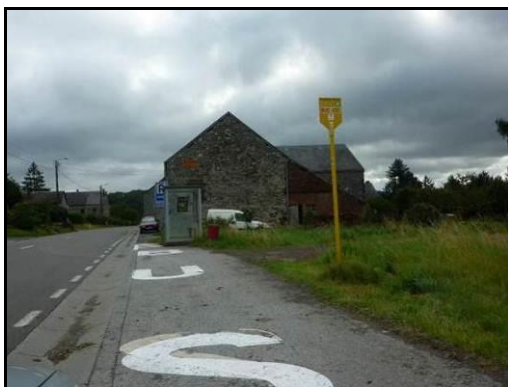
Exemple : Arrêt de bus avec abris et espace de stationnement pour le bus hors de la voirie de circulation, marquage surdimensionné, commune de Rochefort.
