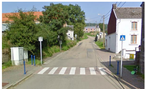
Abaissement des bordures et guides pour malvoyant sur Marche-en-Famenne
