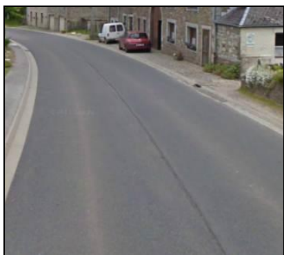
Rue Grande à Fisenne
