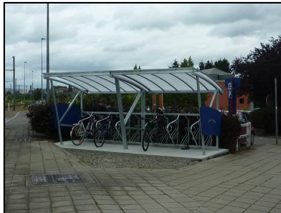
Photo 15 : Parking vélos à Marloie
