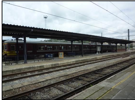
Photo 19 : Quais bas à Jemelle
