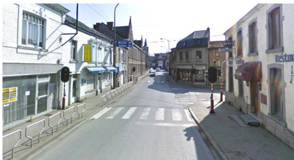
Cheminement correct voirie En Charotte
