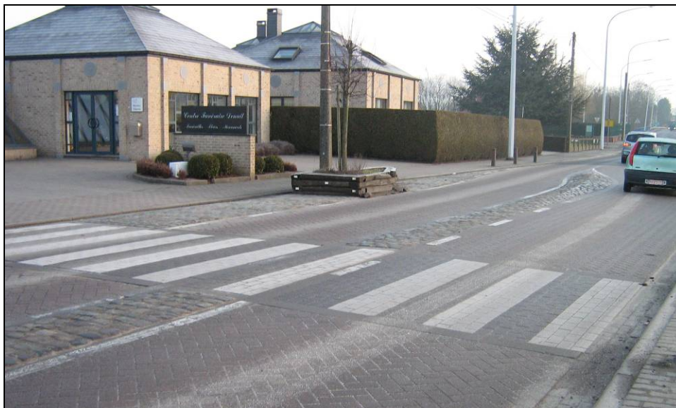
Exemple d'aménagement d'une bande centrale pavée franchissable
