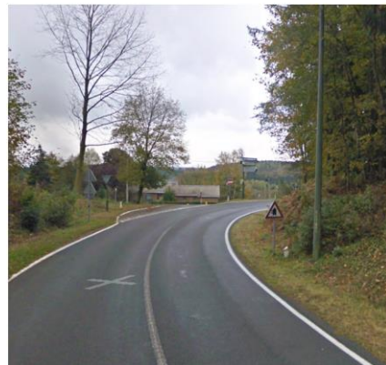
Venant de la N88 côté sud
