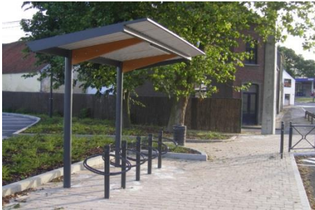
Exemple : abri-vélo à Sombrefe.
