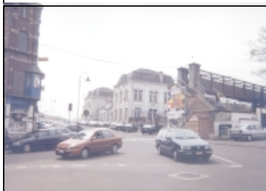
Passerelle - Gare de Taminés
