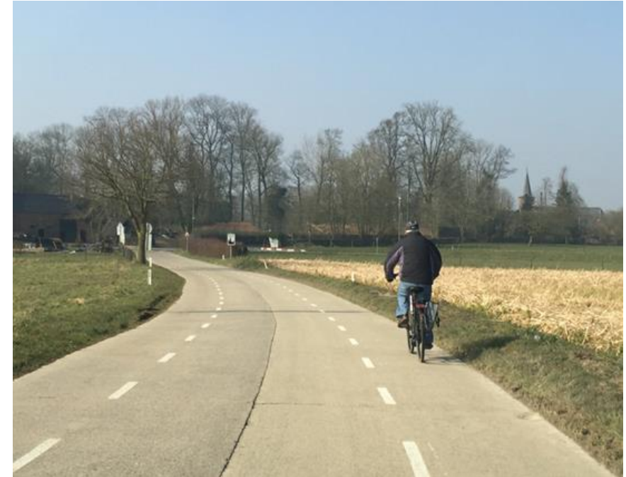
Chaussée à voie centrale de Walhain Source : Walhain.be
