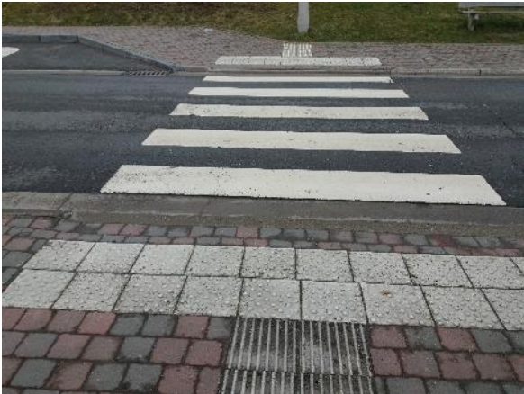
Abaissement et dalles podotactiles
