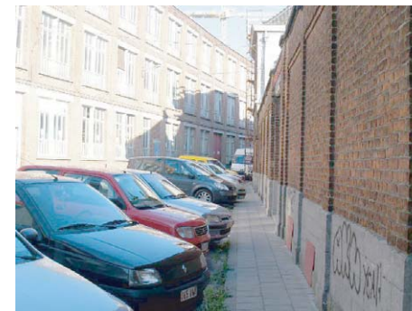
Val Escaut - rue des Six Filles
